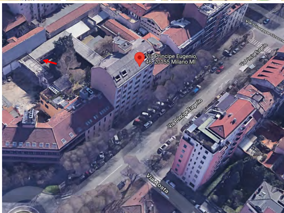
Inquadramento territoriale - vista aerea del fabbricato e individuazione nel cortile del fabbricato autorimesse
