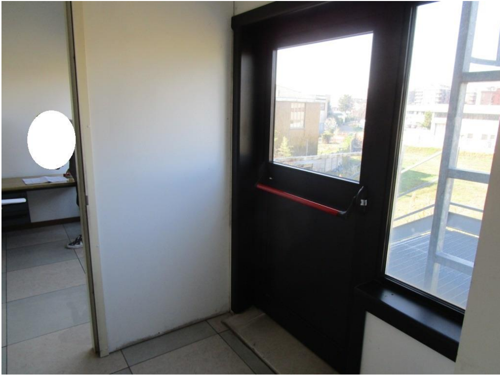
DISIMPEGNO VERSO L'USCITA DI EMERGENZA E LA PORZIONE "UFFICIO – LABORATORIO"
