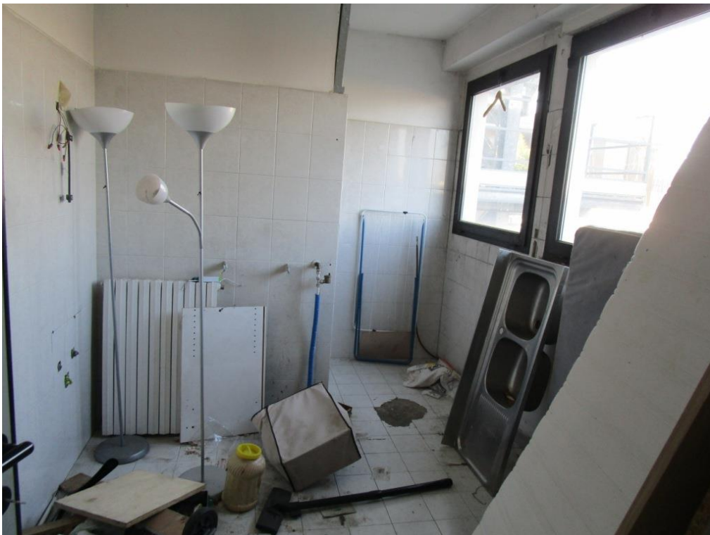
"UFFICI" ADIBITI AD APPARTAMENTI
