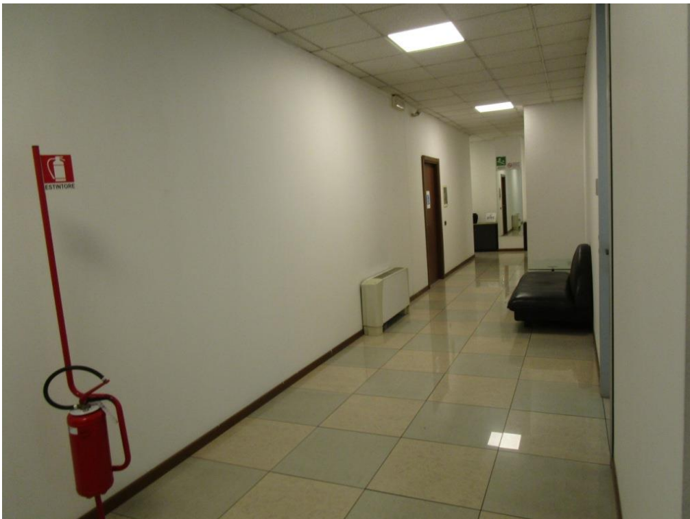
CORRIDOIO DI ACCESSO AGLI UFFICI
