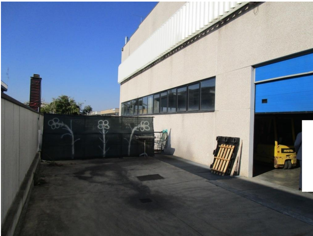
AREA ESTERNA AL PIANO TERRA CON ACCESSO DA VIA TIEPOLO
