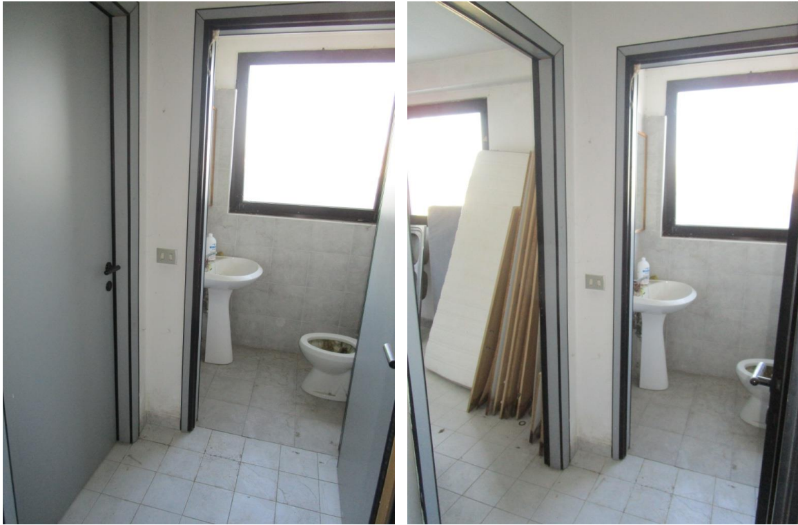
SERVIO IGIENICO ALL'INTERNO DELL'UFFICIO ADIBITO AD APPARTAMENTO
