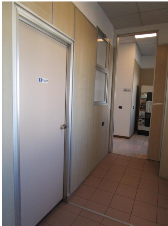
SERVIZI IGEINICI CON ACCESSO DAL CORRIDOIO
