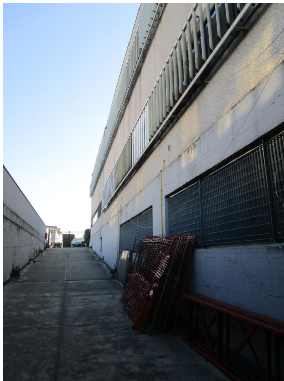
RAMPA DI ACCESSO AL PIANO INTERRATO
