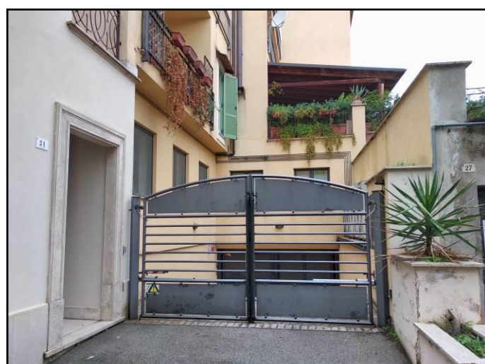
Vista esterna – angolo E
