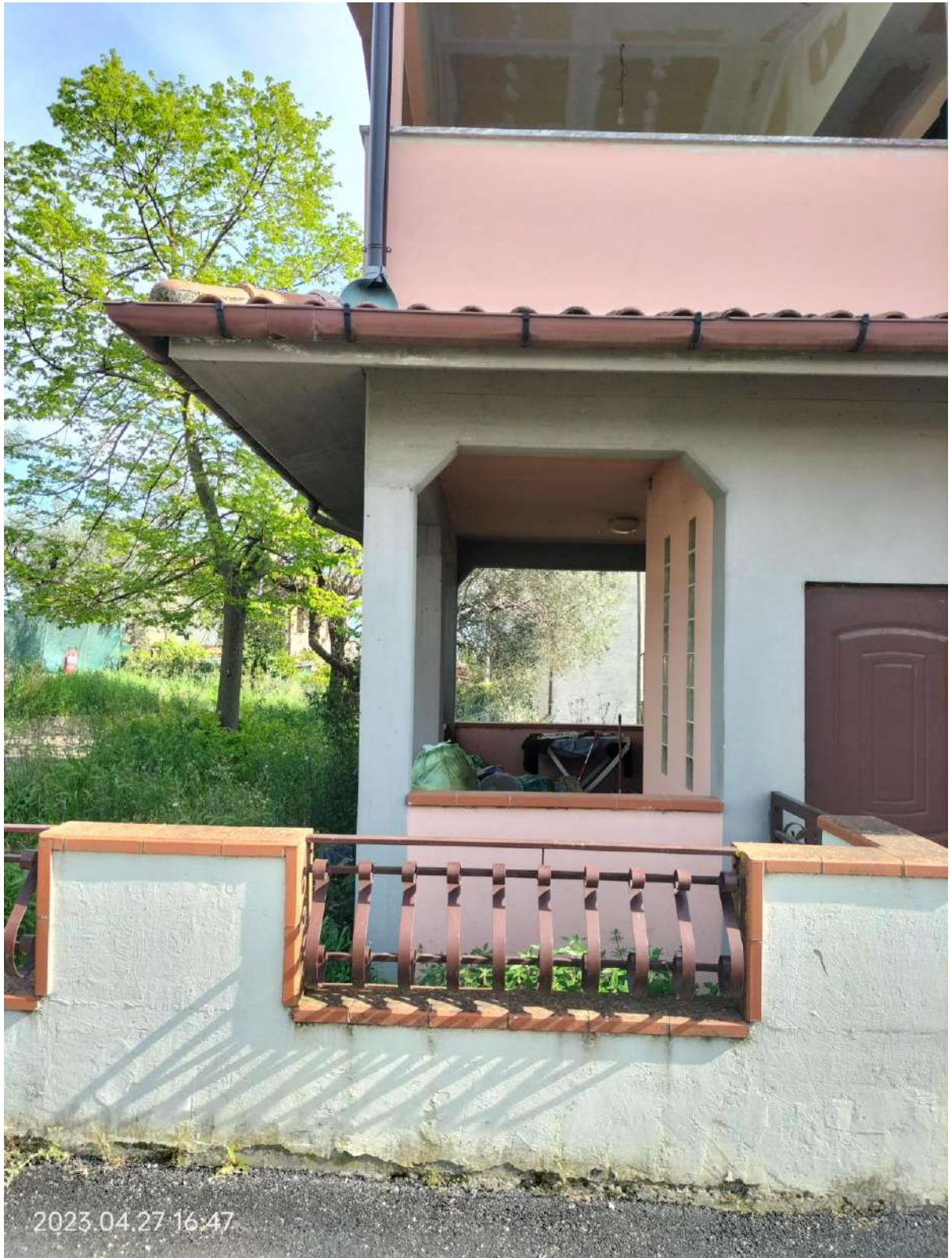
esterno fabbricato - vista del portico lato est dalla strada di accesso
