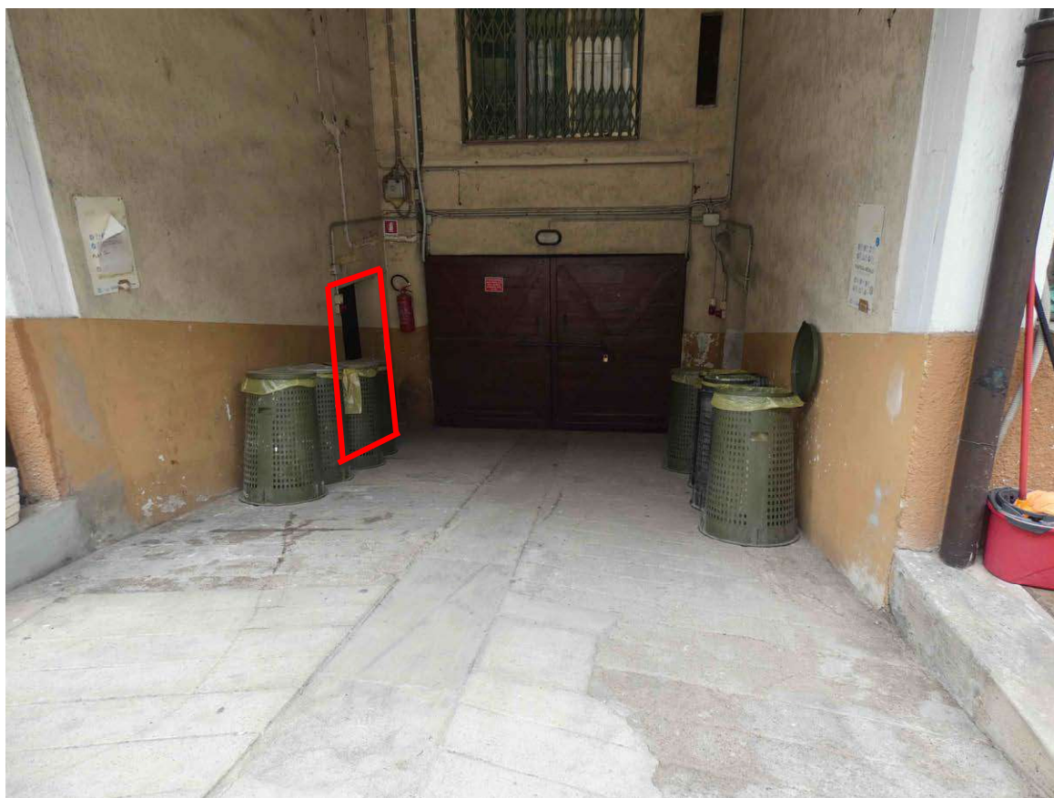
Foto 9. Rampa e porta d'accesso alle cantine
