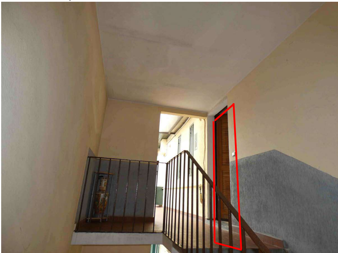
Foto 5. Pianerottolo di sbarco al piano secondo
