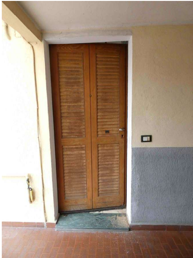
Foto 6. Porta d'accesso all'appartamento
