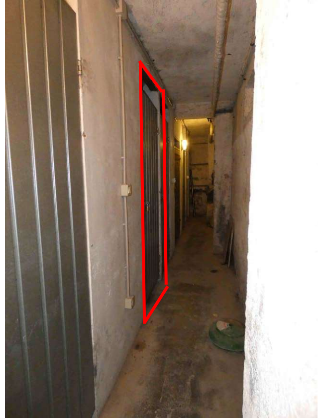
Foto 11. Porta d'accesso alla cantina
