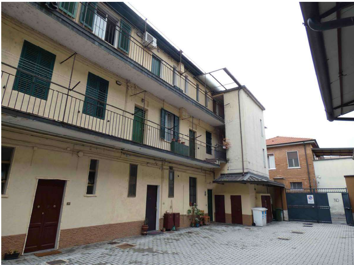
Foto 2. Prospetto su cortile del fabbricato in cui è ubicato l'immobile oggetto di pignoramento
