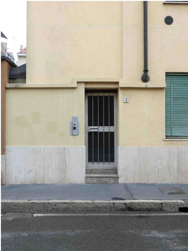
Foto 3. Portone d'accesso al civico 3 di Via XXV Aprile
