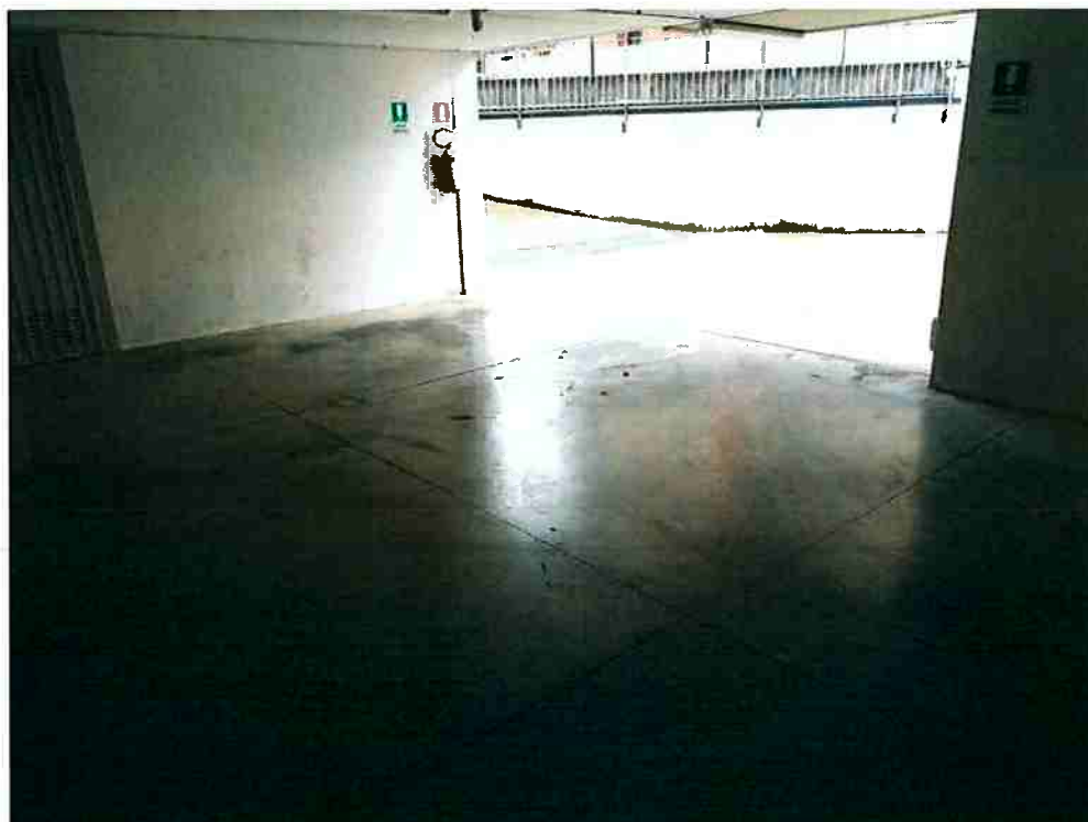
Foto 11 vista dell'ingresso all'autorimessa.
