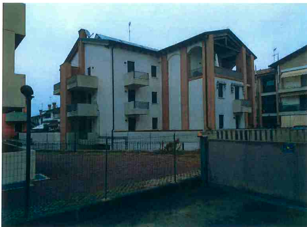
Foto 2 Vista del condominio.
