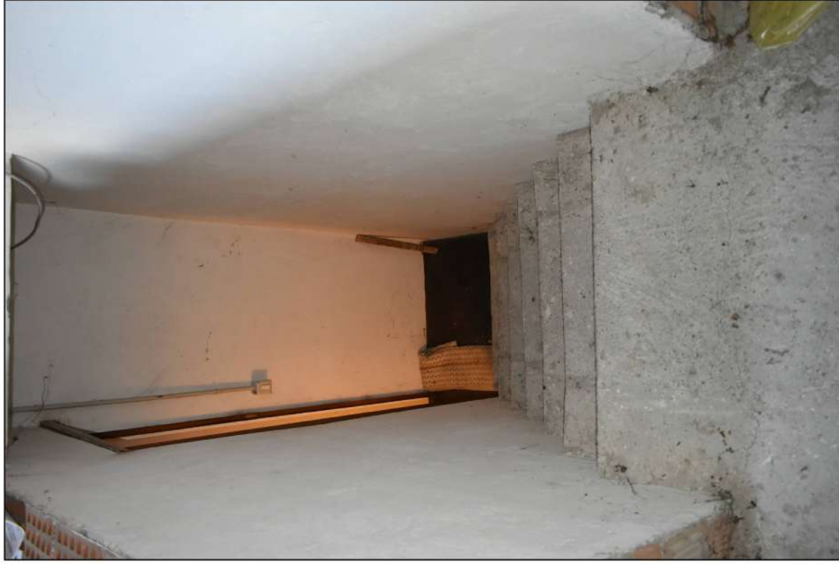
foto 24 - scala accesso sottotetto
