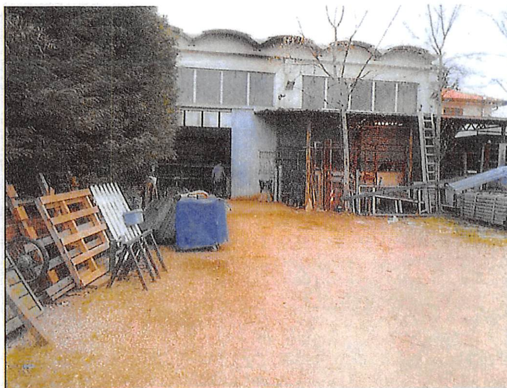
Foto n° 10 : Capannone produttivo – vista esterna – Lotto 1.
