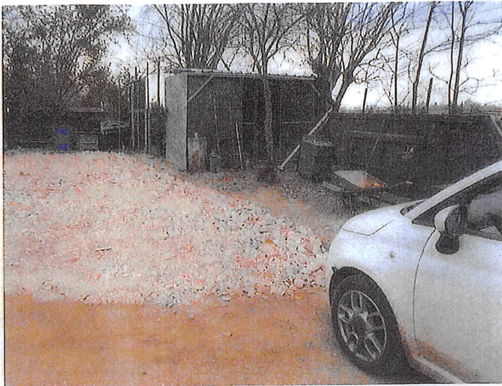
Foto n° 3 : Tettoia in difformità nel fronte Est del lotto – Lotto 1.
