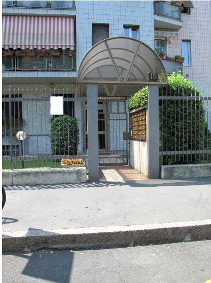
esterno fabbricato - ingresso pedonale
