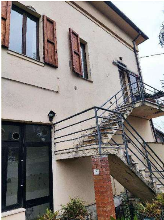
FACCIATA SUD (SCALA)
