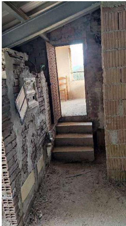
INGRESSO SOFFITTA DA ALTANA/TORRINO
