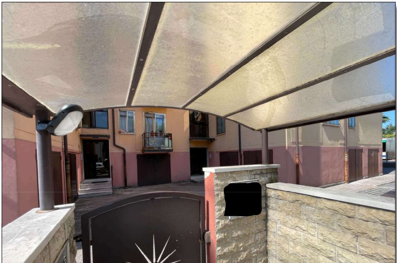
Foto n. 4) Vista dell'ingresso posto su via Lissa
