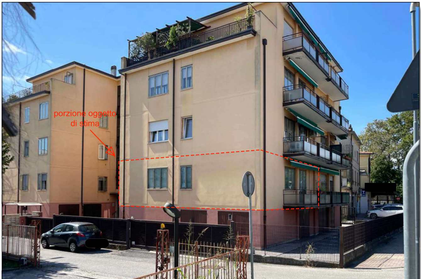
Foto n. 2) Vista dei prospetti nord/est e nord/ovest con affaccio rispettivamente su via Lissa e via Miranese
