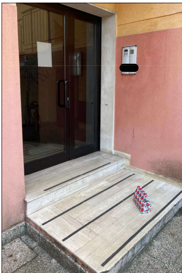
Foto n. 6) Vista portone di ingresso al vano scale
