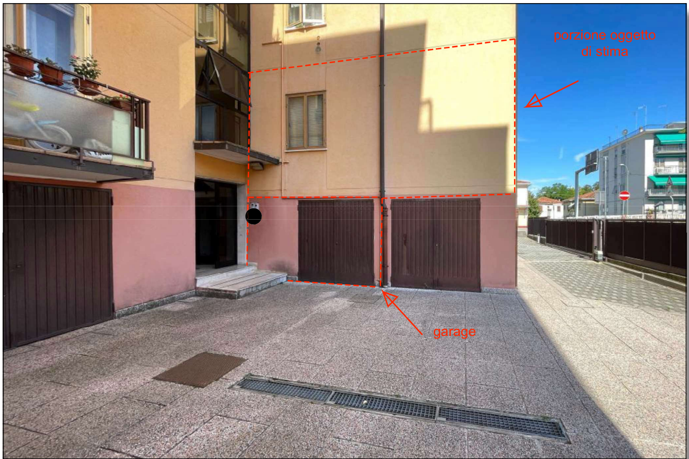
Foto n. 3) Vista del prospetto sud/est
