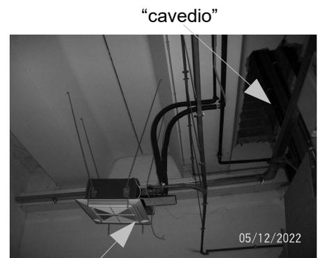
Foto C split collegati al macchinario in copertura ma non funzionante
