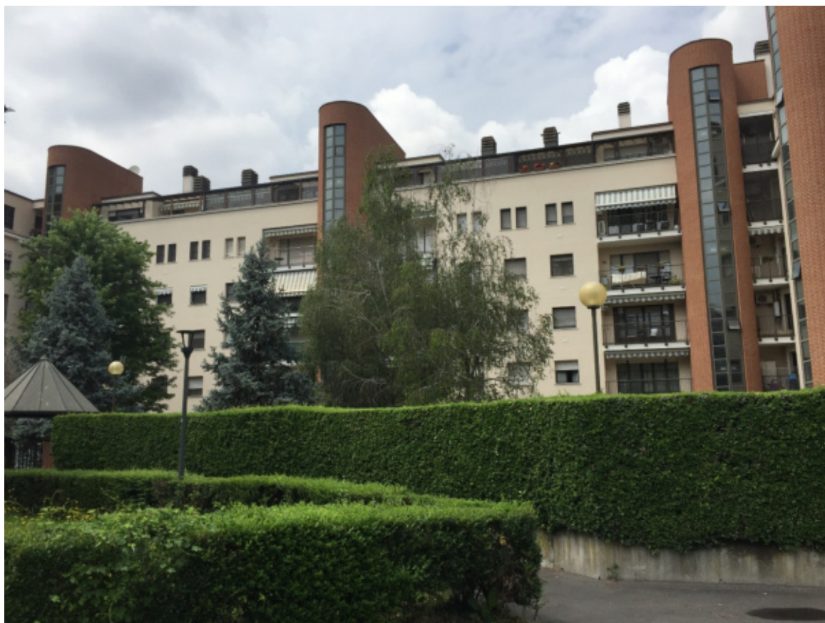
Foto 02 - Il fabbricato su via Trasimeno
