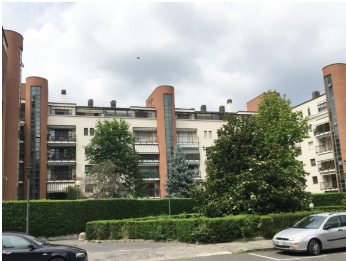
Foto 01 - Il fabbricato su via Trasimeno
