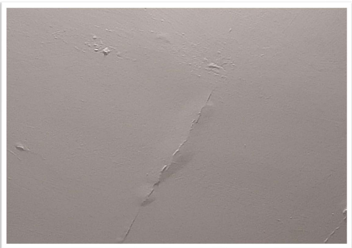
**FOTO 19: PARTICOLARE UMIDITA' SOFFITTO BAGNO**
