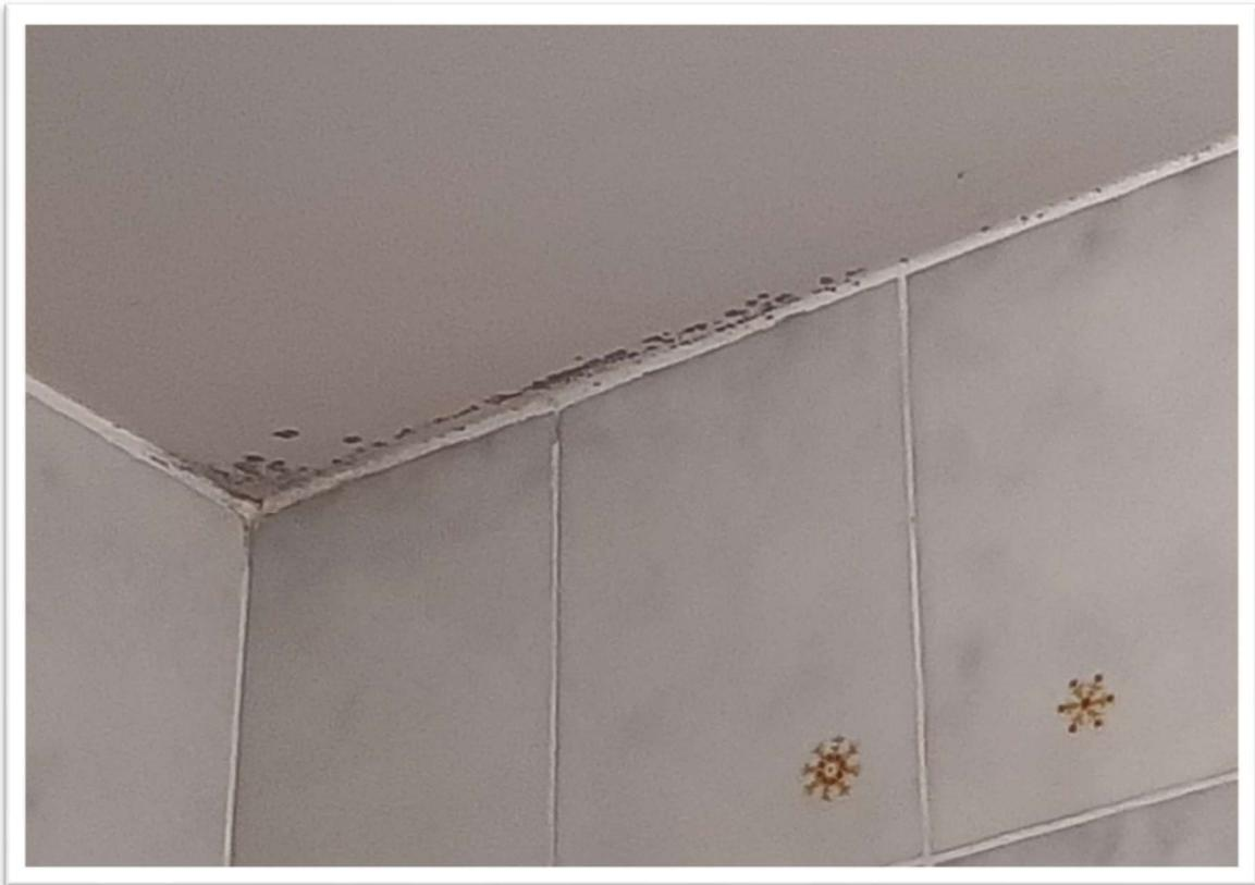
**FOTO 18: PARTICOLARE UMIDITA' SOFFITTO BAGNO**
