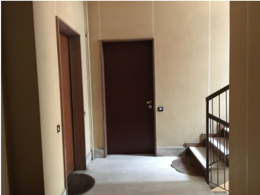
FOTO 3: CORNAREDO, VIA VANZAGO 48, ingresso immobile
