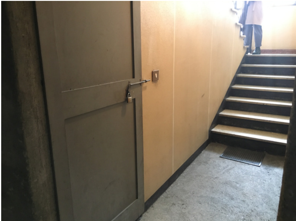
FOTO 11: CORNAREDO, VIA VANZAGO 48, ingresso cantina
