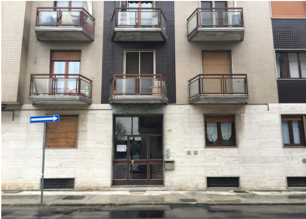
FOTO 1: CORNAREDO, VIA VANZAGO 48, facciata edificio
