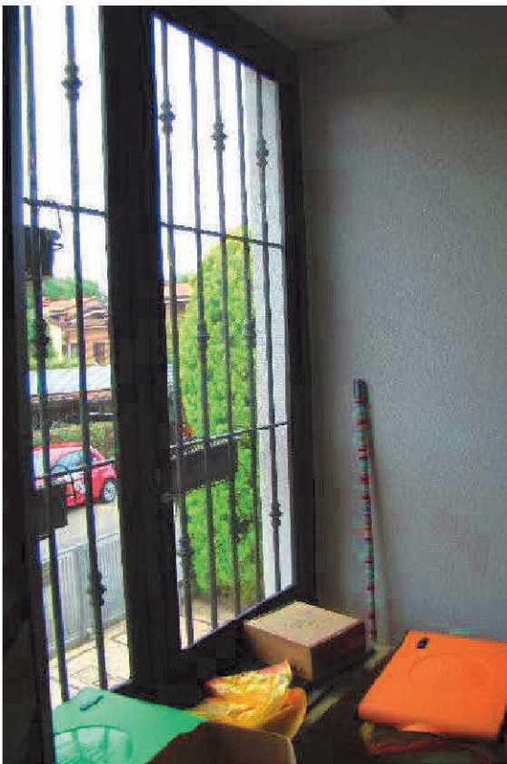
20. Dettaglio del serramento del balcone.
