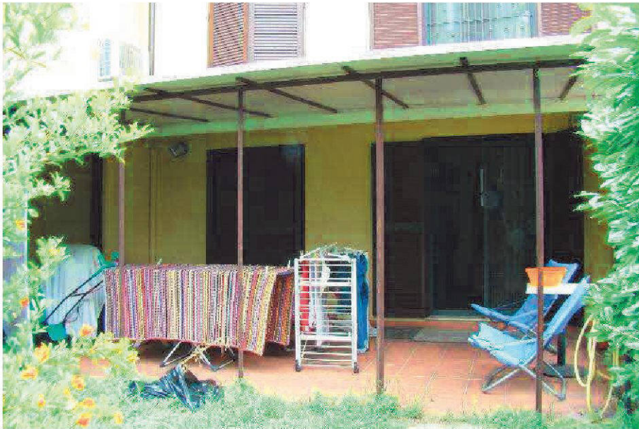
23. Dettaglio della tettoia.
