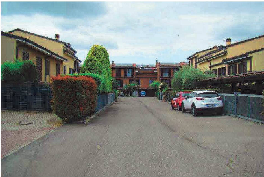
4. Vista del vialetto interno di accesso all'immobile.
