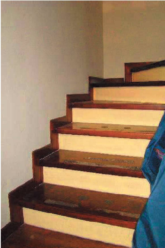
15. Dettaglio della scala.
