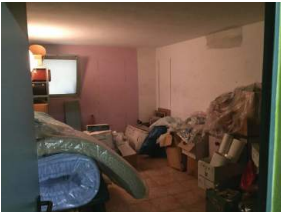
Foto n.17 – P. Cantinato – cantina 1
