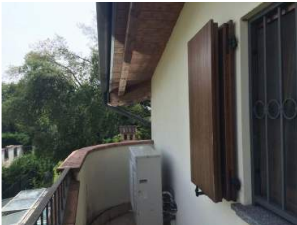
Foto n.9 – P. Primo – balcone lato nord
