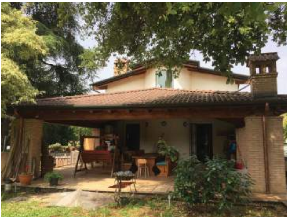
Foto n.25 – Portico lato est
