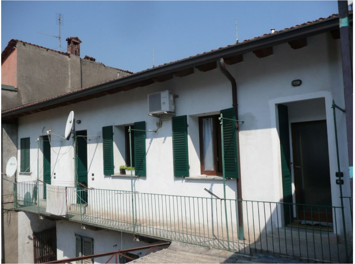
FACCIATA SU CORTILE INTERNO ANTERIORE FOTO 2
