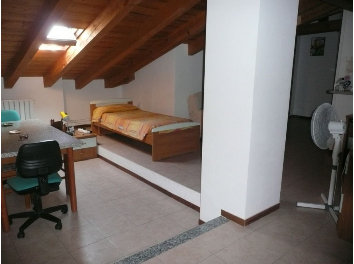
SOTTOTETTO NON ABITABILE FOTO 1
