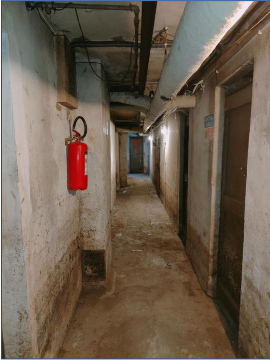
Foto 9 - spazi comuni accesso piano cantine
