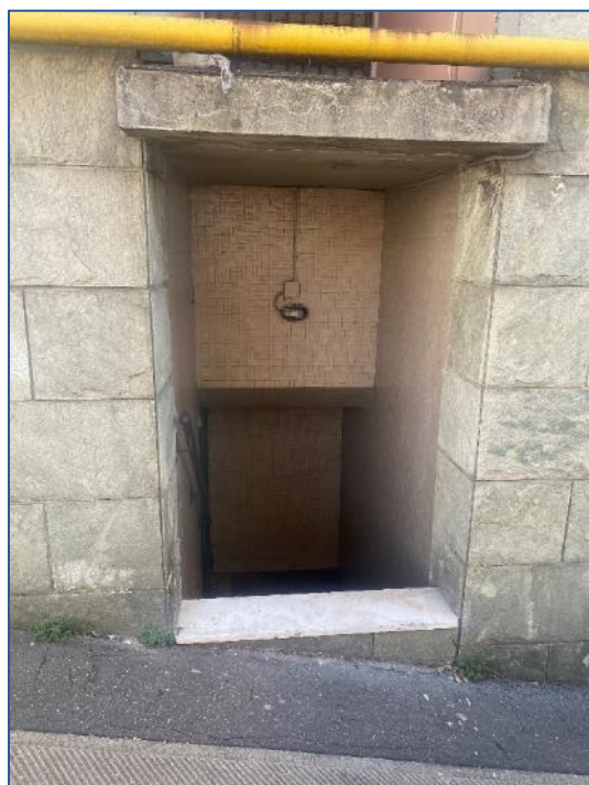
Foto 4 - spazi comuni accesso piano cantine
