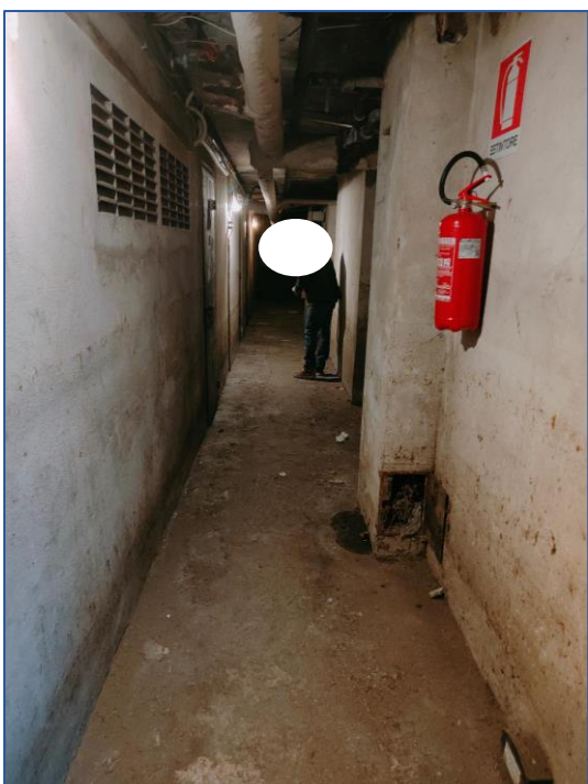
Foto 7 - spazi comuni accesso piano cantine
