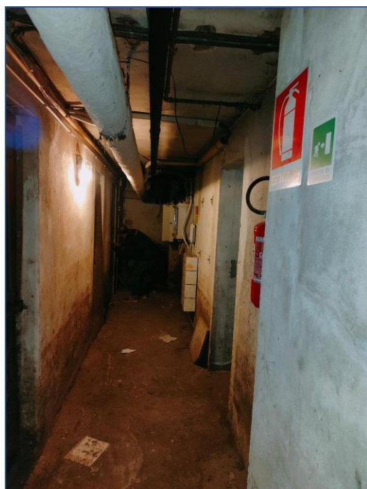
Foto 8 - spazi comuni accesso piano cantine
