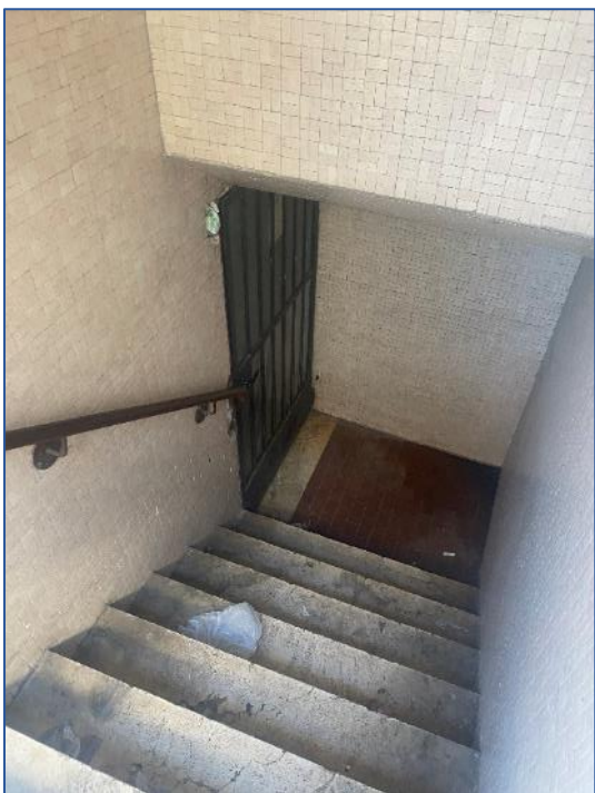
Foto 5 - spazi comuni accesso piano cantine
