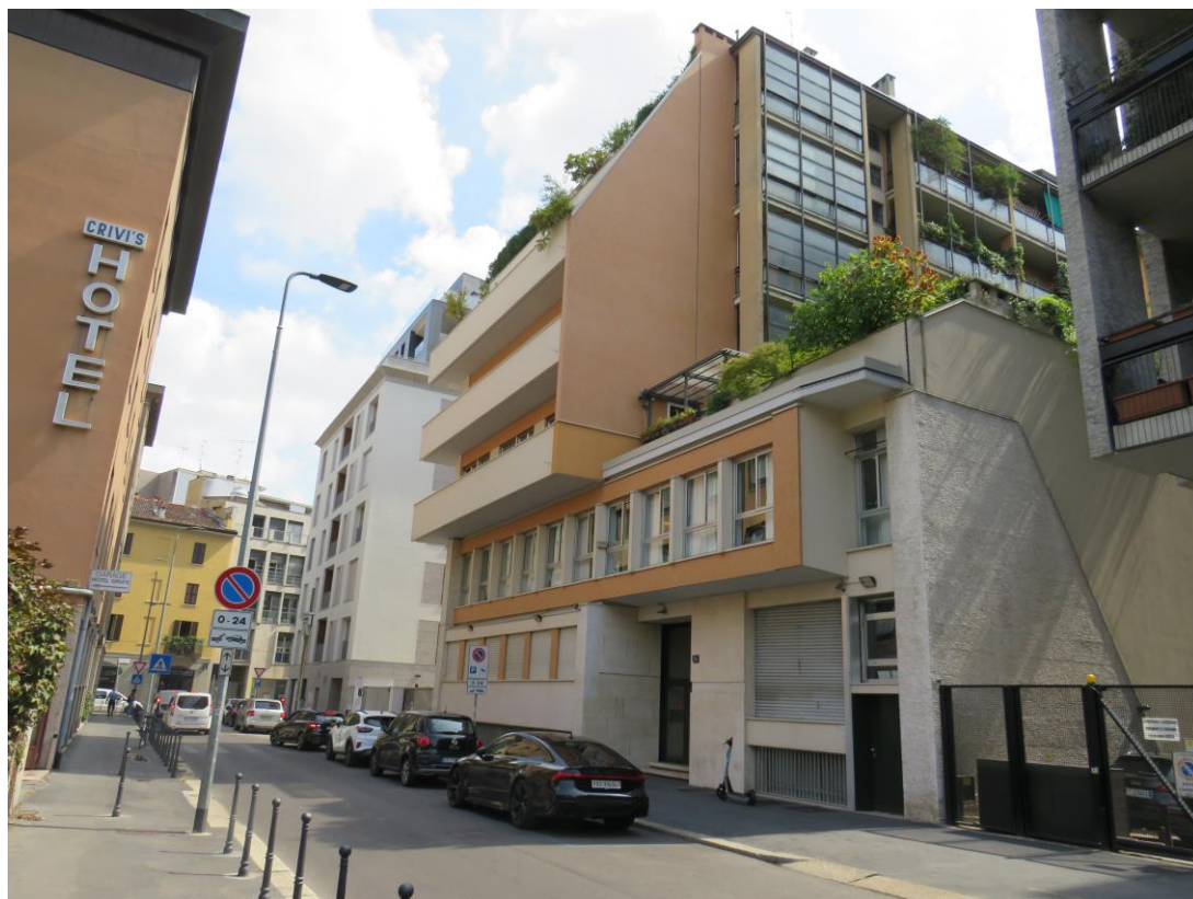
FACCIATA SU VIA CRIVELLI
