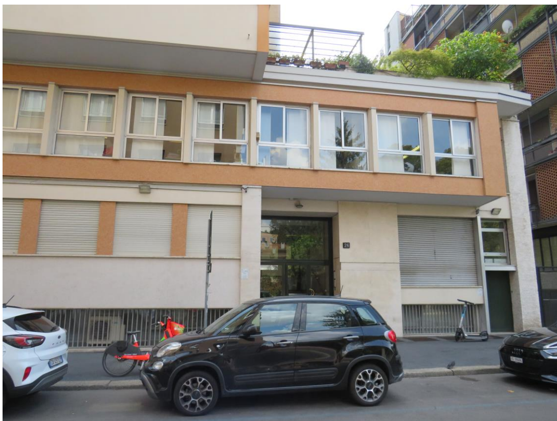
FACCIATA SU VIA CRIVELLI
