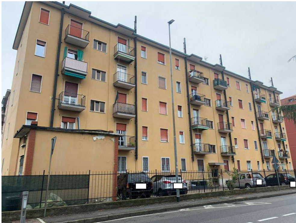
Fotografia n. 1 – Vista del Condominio Cassanese – Via Roma n. 76 Segrate (Mi) - lato Via Carlo Alberto dalla Chiesa, su cui affacciano sulla destra al piano secondo i locali (bagno e cucina con balcone) dell'appartamento oggetto della procedura
