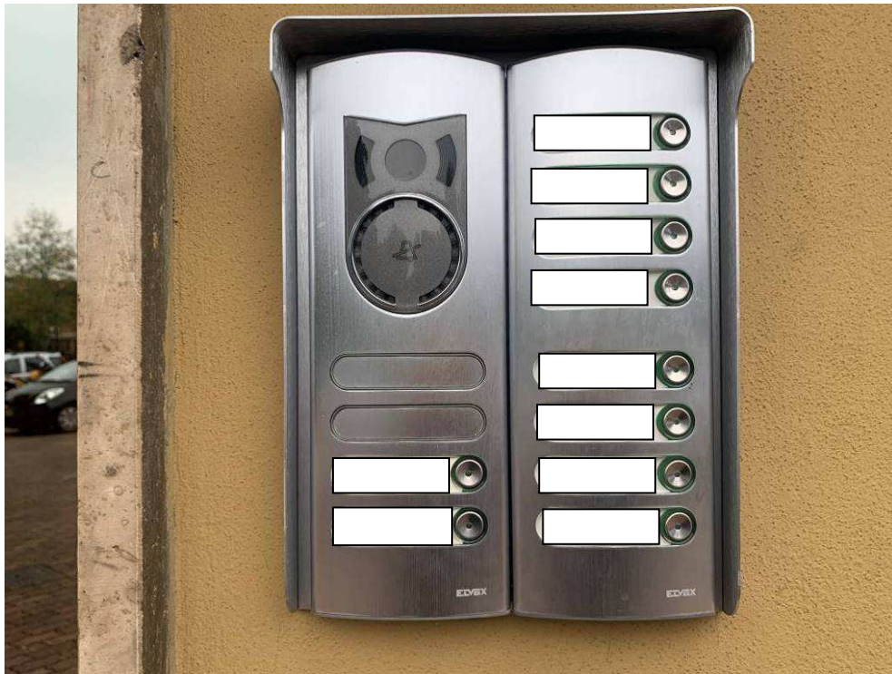
Fotografia n. 11 – Particolare del citofono in corrispondenza del portone di accesso alla Scala C, dove compaiono i nomi dei due debitori occupanti l'unità immobiliare oggetto della procedura
