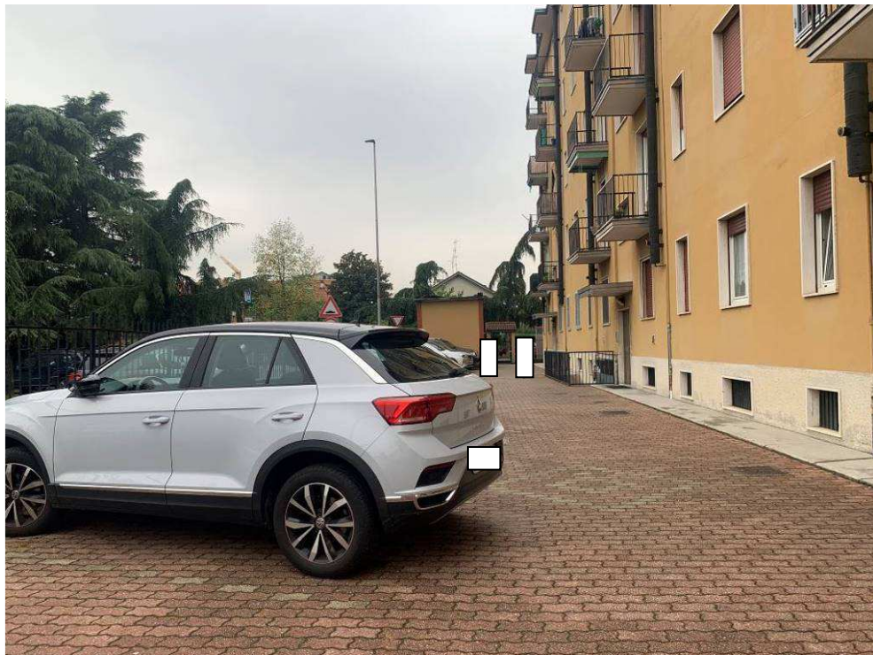
Fotografia n. 9 – Particolare del cortile interno – lato Via Carlo Alberto dalla Chiesa, dove si trovano gli accessi ai corpi Scala A-B-C
