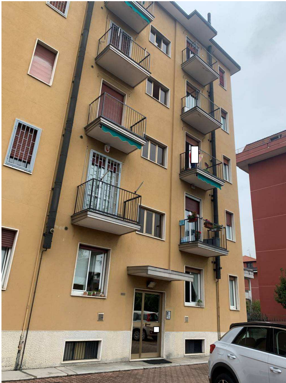
Fotografia n. 10 – Particolare del Condominio Cassanese – Via Roma n. 76 Segrate (Mi) con portone di ingresso alla Scala C, dove sulla destra al piano secondo si trova l'appartamento oggetto della procedura
