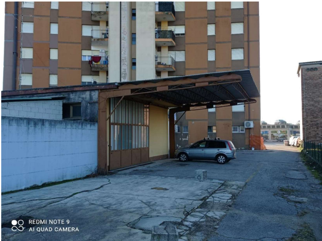
Tetteria retro lotto 001 – da demolire
