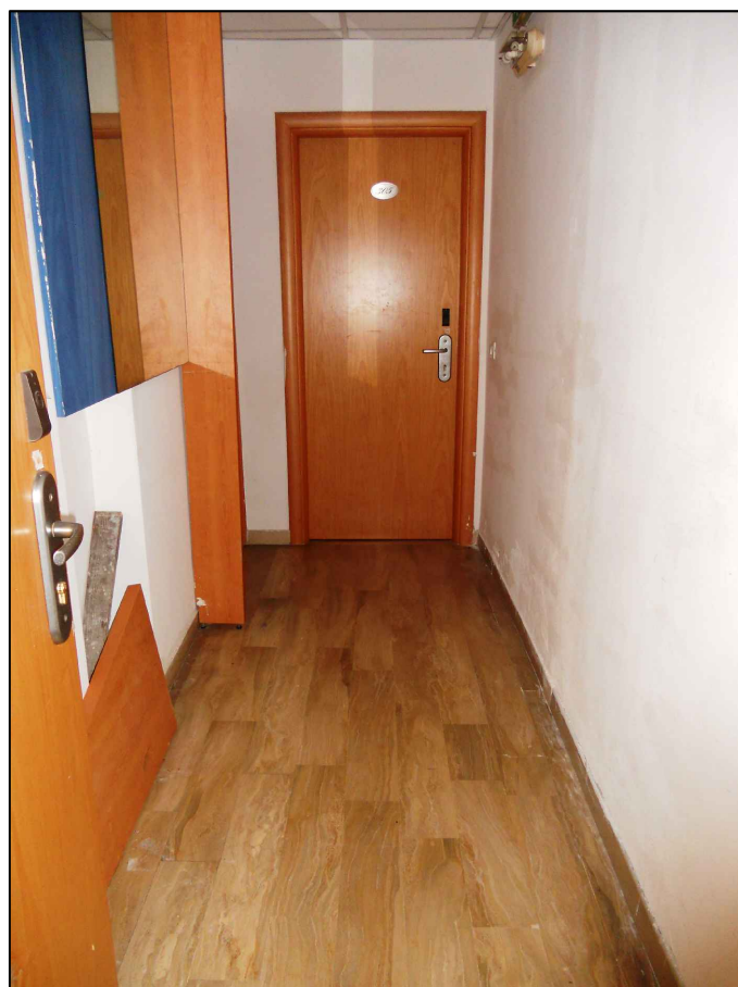
FOTO N°8 - VISTA CORRIDOIO 1°P.
