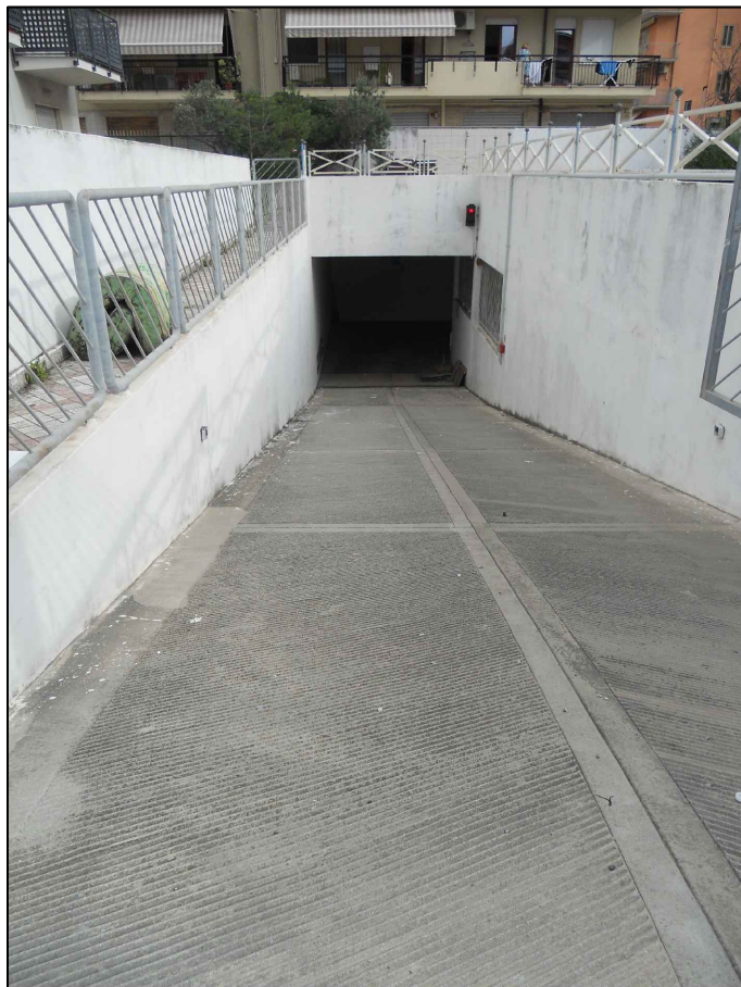
FOTO N°1 - VISTA DELLA RAMPA CARRABILE
