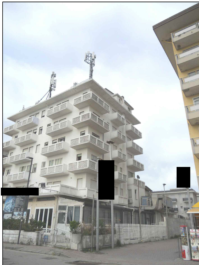
FOTO N°13 - VISTA DA NORD-EST
