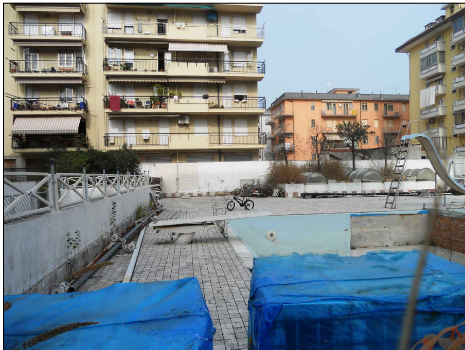
FOTO N°7 - VISTA DELLO SCOPERTO DA SUD
