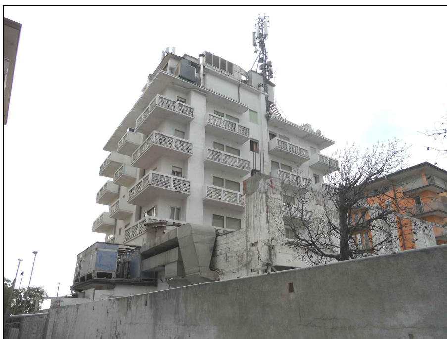
FOTO N°14 - VISTA DA NORD-OVEST
