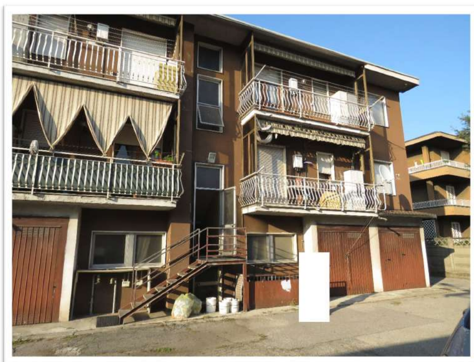
Particolare dell'ingresso dal retro dell'edificio.
