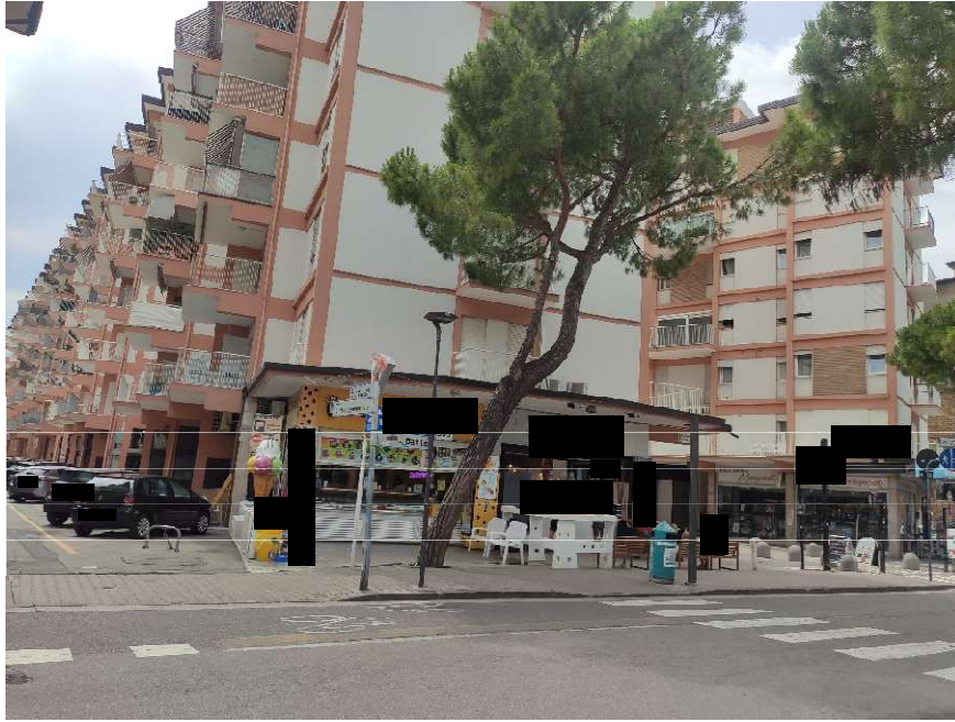
FOTO N. 3 – prospetto nord-est del condominio
