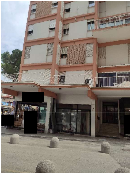
FOTO N. 5- prospetto ovest e ingresso del condominio
