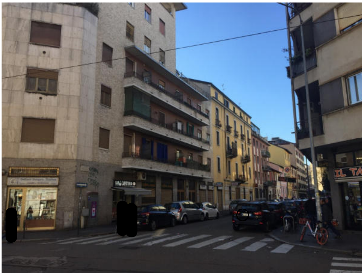
Foto 01 - I fabbricati in via Giovanni Battista Casella
