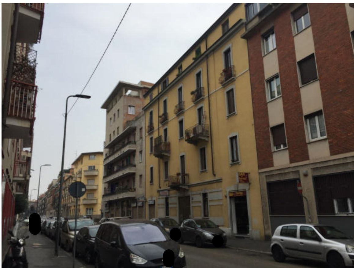
Foto 02 - I fabbricati in via Giovanni Battista Casella
