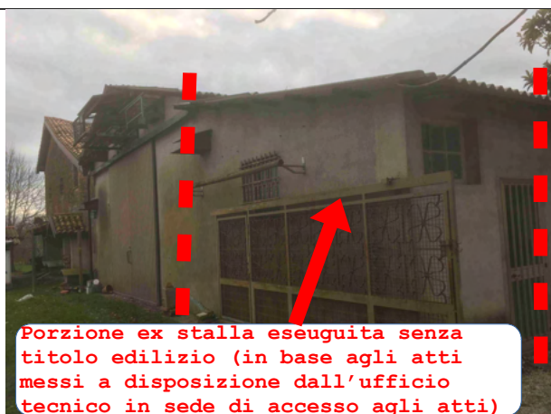
Veduta esterna porz. ex stalla
