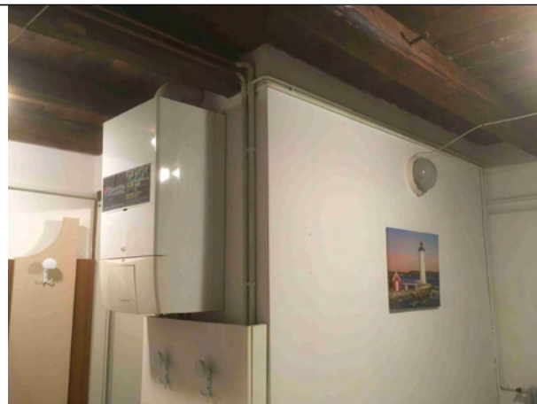
Particolare camera p. T
