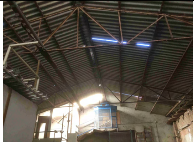
Veduta ex stalla lato ovest p. T
