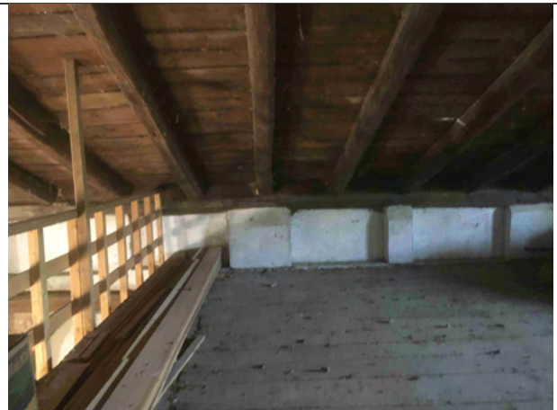
Veduta ex stalla porz. centrale p. 1 Particolare soppalco
