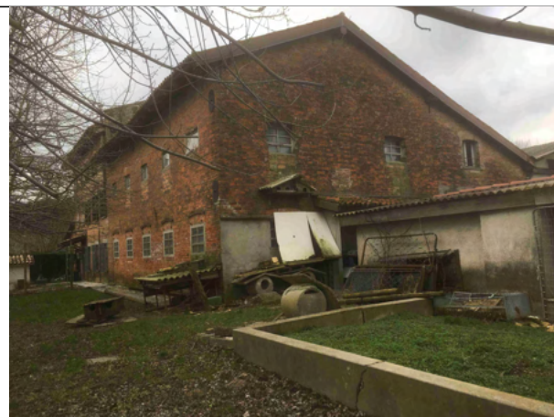
Veduta esterna porz. ex stalla
