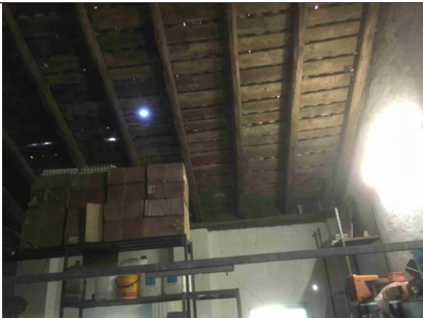
Veduta ex stalla lato est p. 1 Particolare copertura
