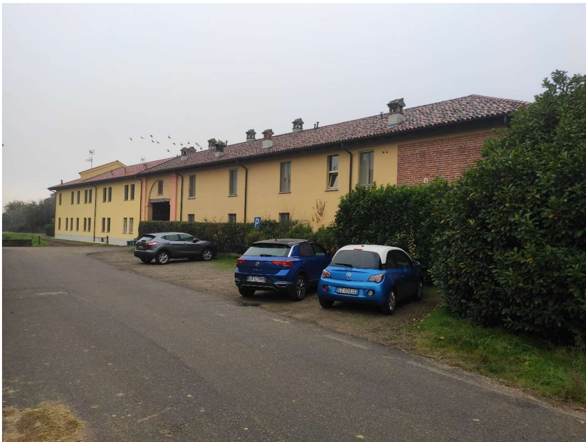
Foto n. 11 – Prospetto principale della cascina
