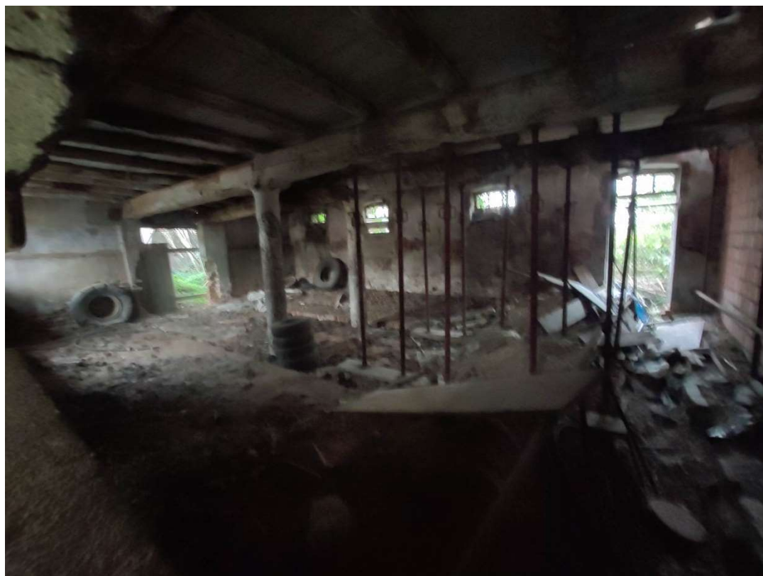
Foto 18 – Veduta interna del sub 703
