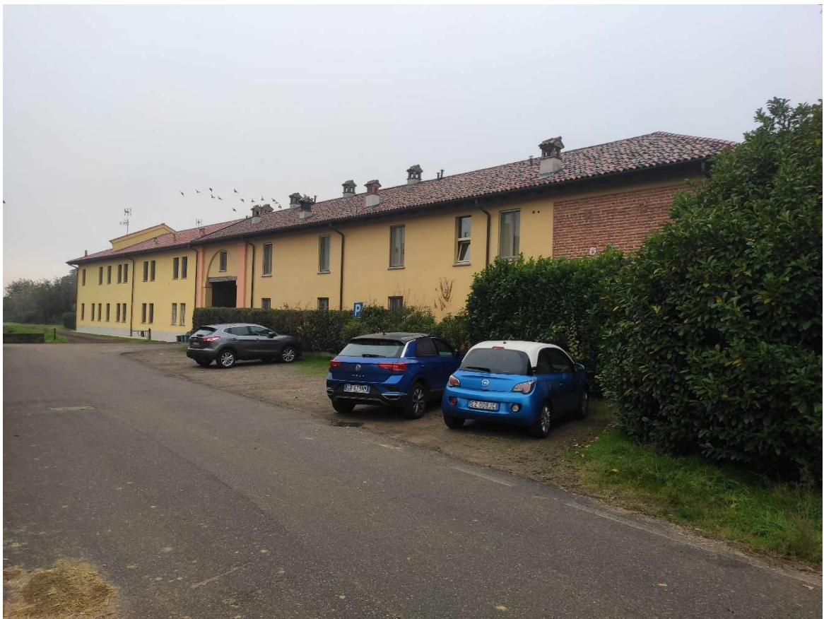
Foto n. 3 – Prospetto principale della cascina
