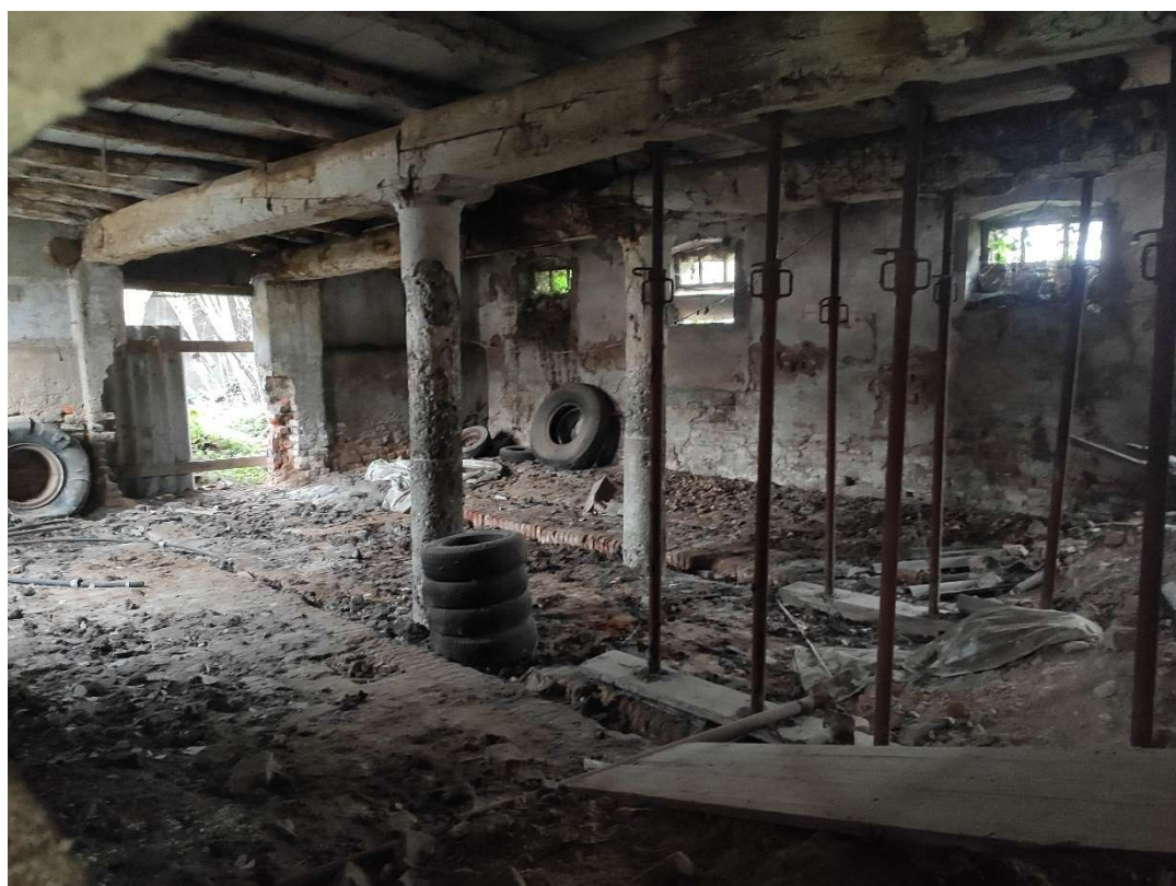
Foto 20 – Veduta interna del sub 703
