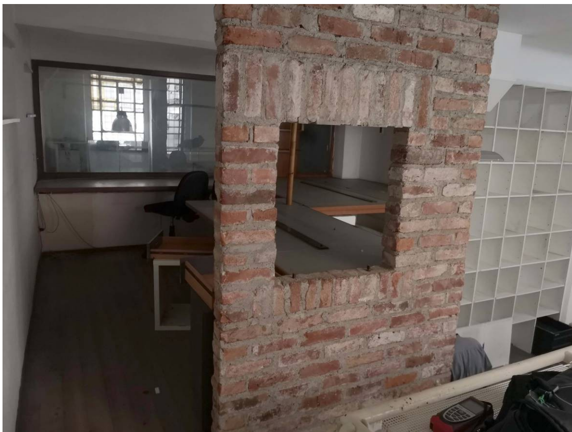
Foto 9 - Vista della parte terminale del soppalco.
