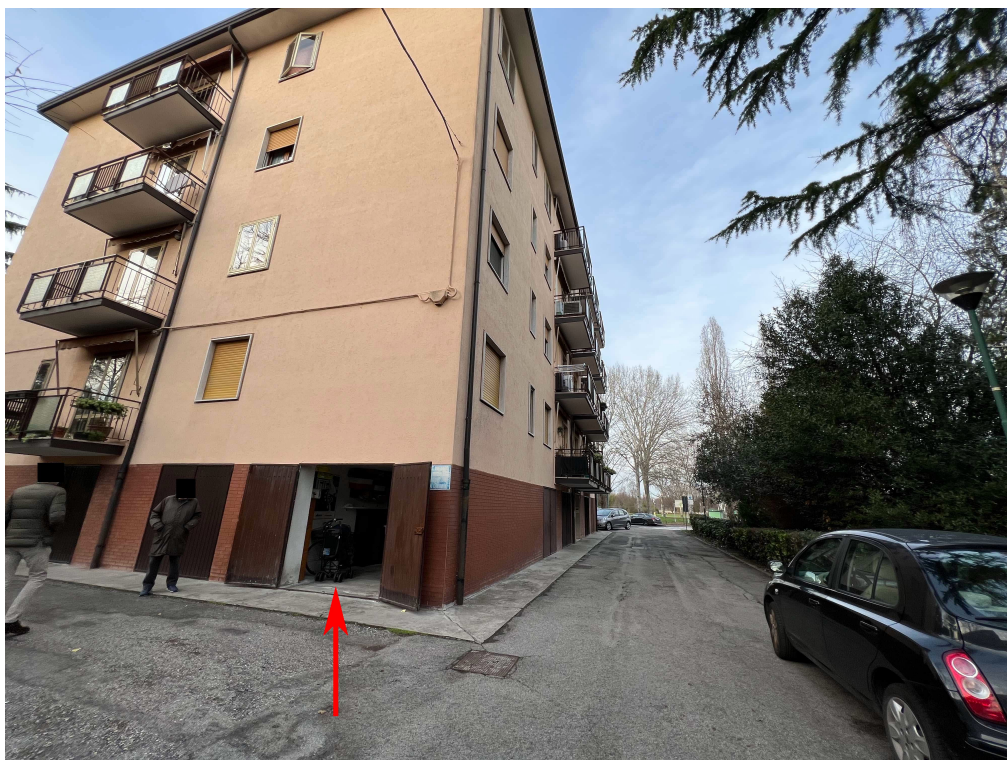
Foto 10 – veduta esterna del garage (corpo B)
