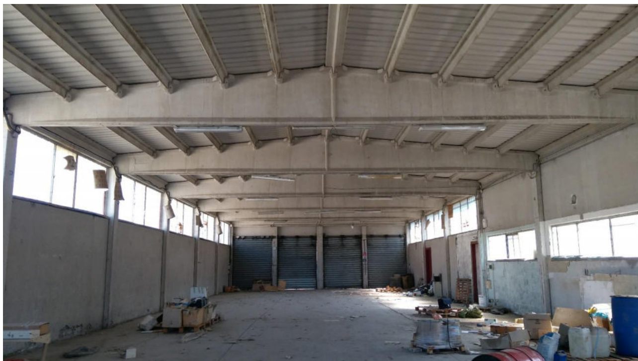
Interno fabbricato – fronte principale (movimentazione merci e ingressi pedonali)
