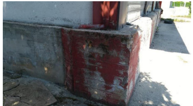
Cemento (esterno Fabbricato)_06
