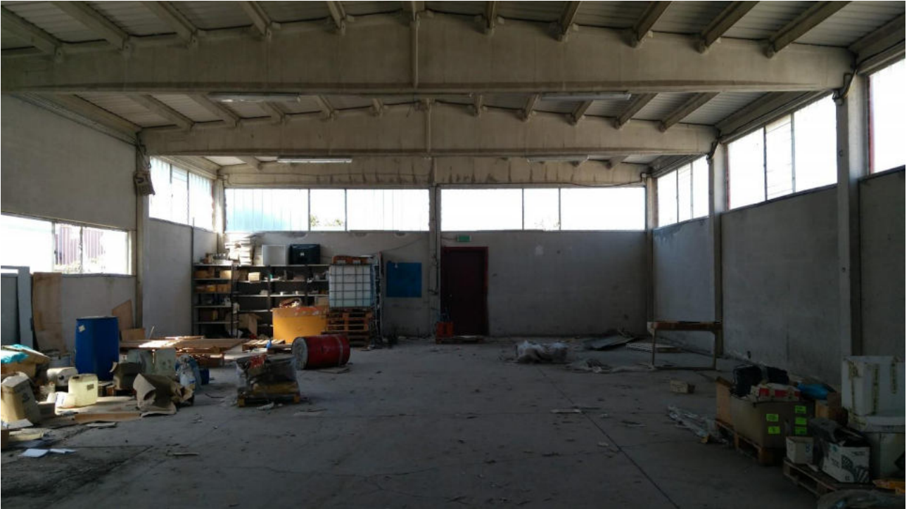
Interno fabbricato – fronte posteriore (movimentazione merci)
