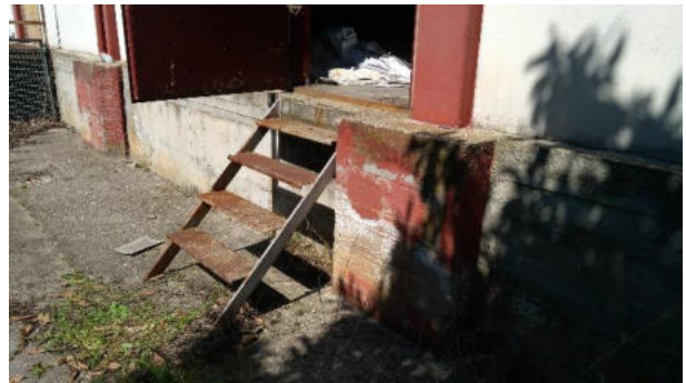
Particolare ingresso laterale_02
