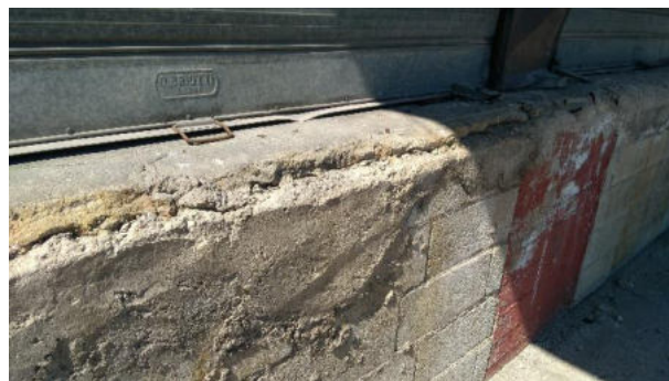
Cemento (esterno Fabbricato)_07
