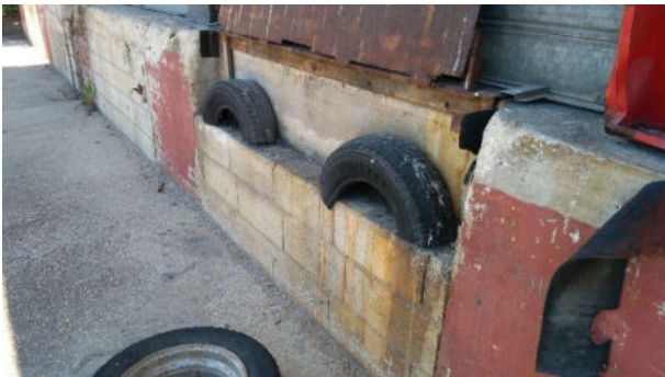
Cemento (esterno Fabbricato)_03
