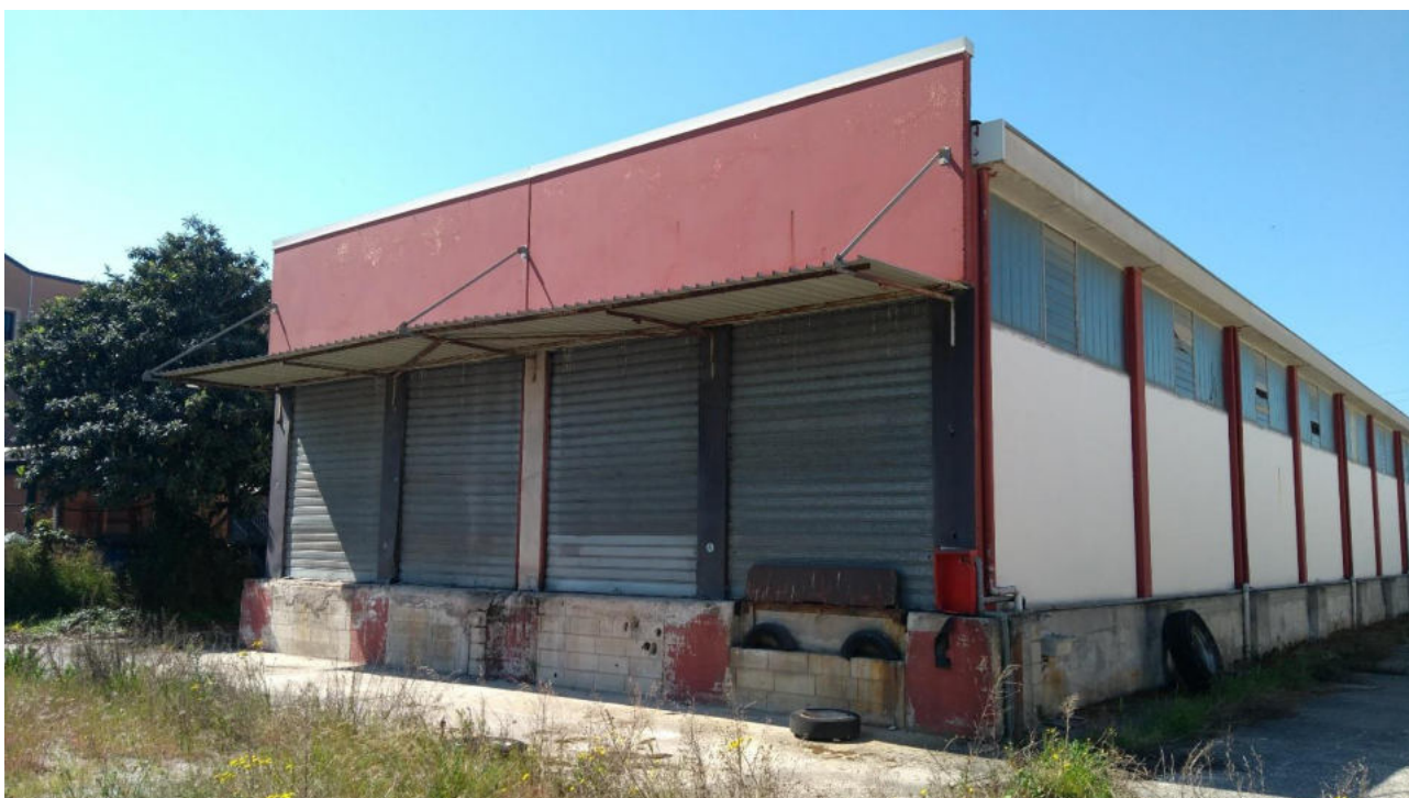
Fronte principale - laterale (movimentazione merci)
