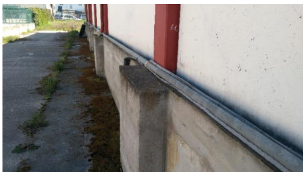
Impianti (esterno Fabbricato)_01
