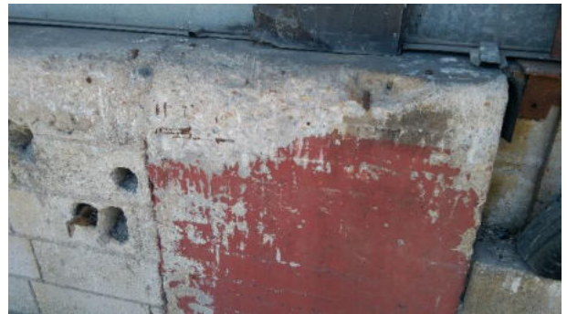
Cemento (esterno Fabbricato)_04
