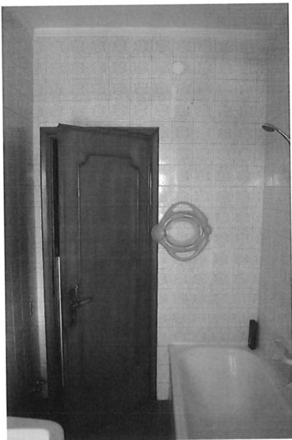
Foto 13. Altra vista su bagno
