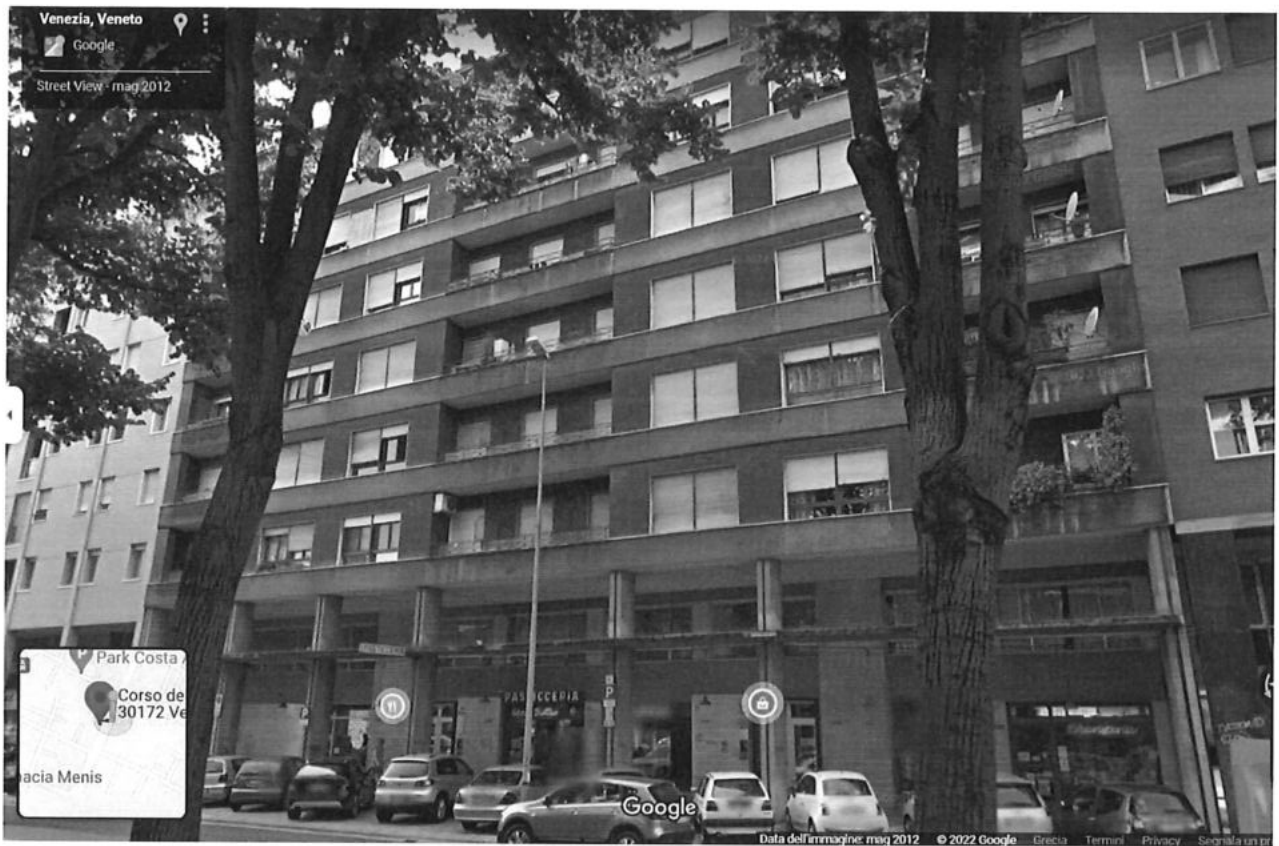
Foto 2. Prospetto Condominio su Corso del Popolo
