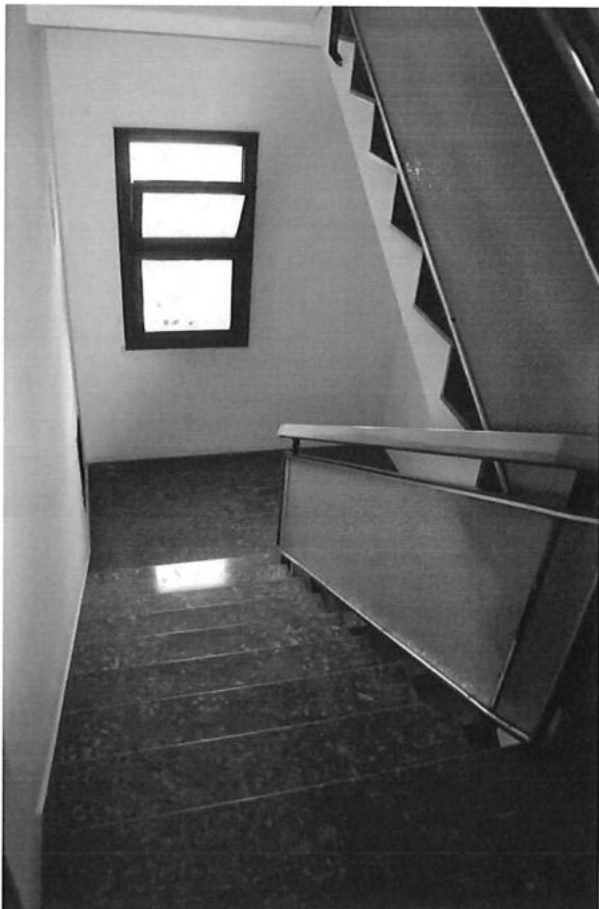
Foto 3. Vano scala condominiale
