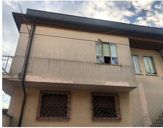
Vista appartamento da Via Garibaldi
