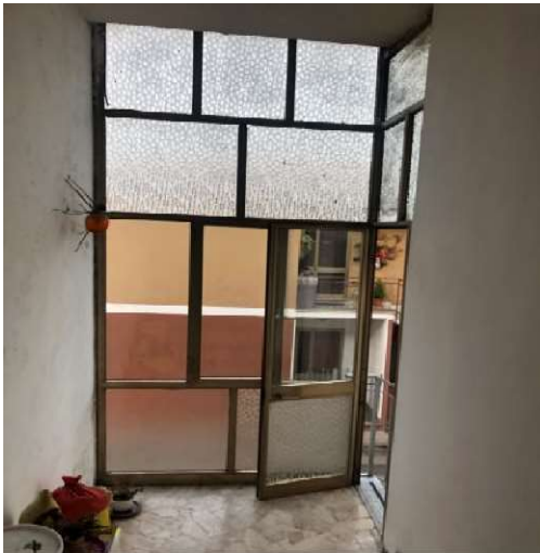
Vista ballatoio di ingresso alle due unità
