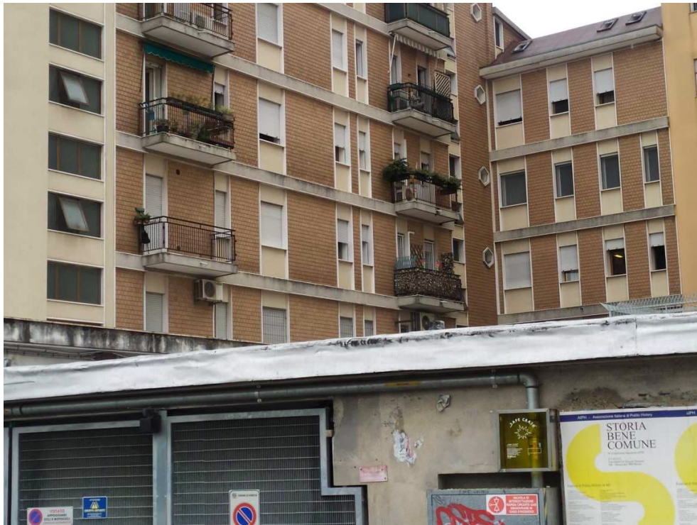
FOTO N. 3 prospetto su via Ponci
