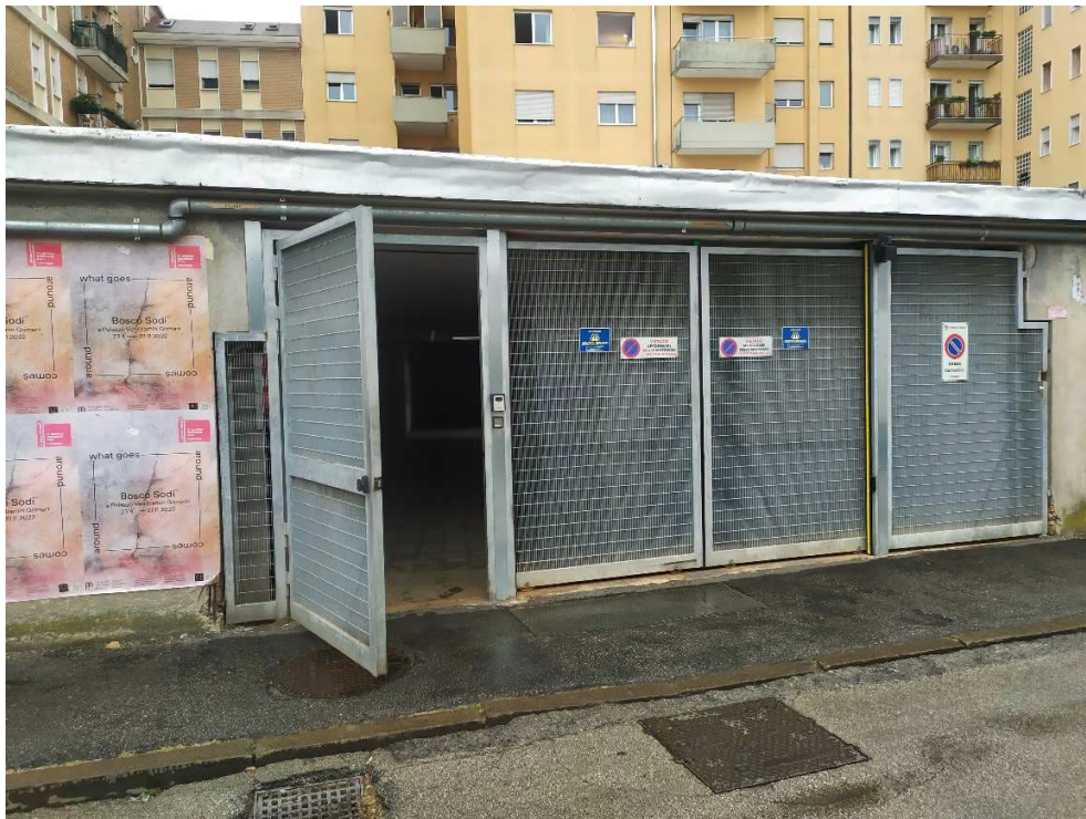
FOTO N. 14 accesso ai garage
