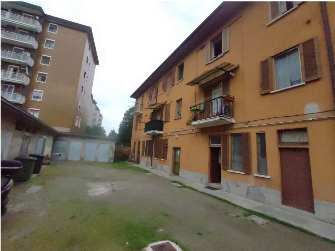
Foto n. 2 – Altro prospetto dell’edificio
