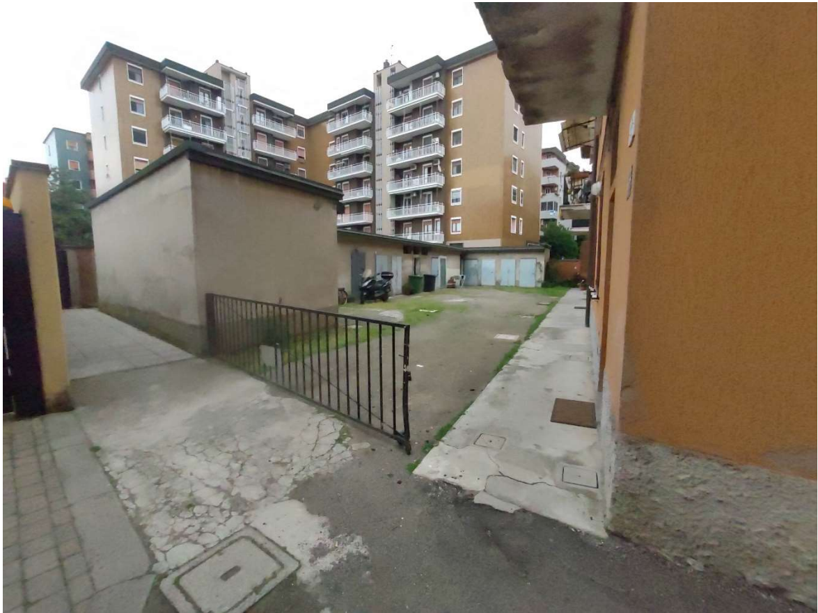
Foto n. 3 – Ingresso al fabbricato
