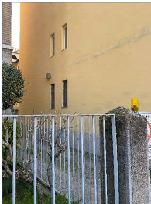
Foto 15 - dettaglio serramenti su corte comune
