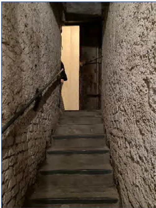
Foto 9 - spazi comuni piano cantine
