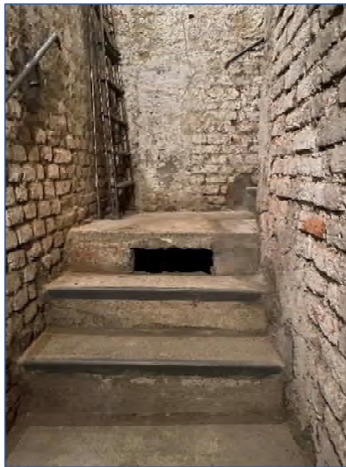
Foto 10 - spazi comuni piano cantine
