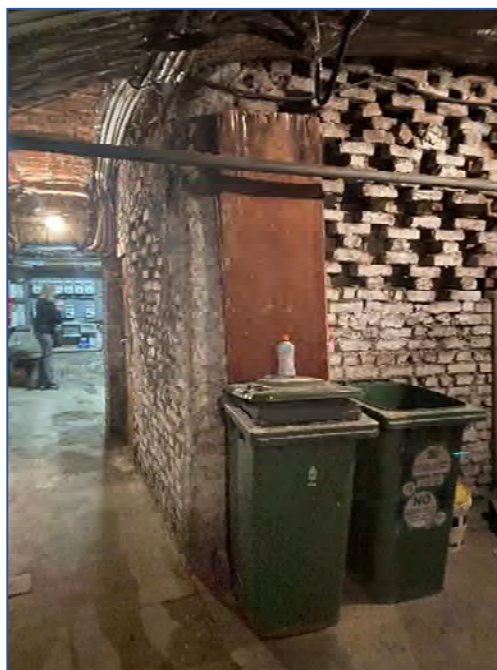
Foto 12 - spazi comuni piano cantine
