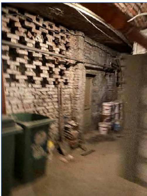
Foto 11 - spazi comuni piano cantine
