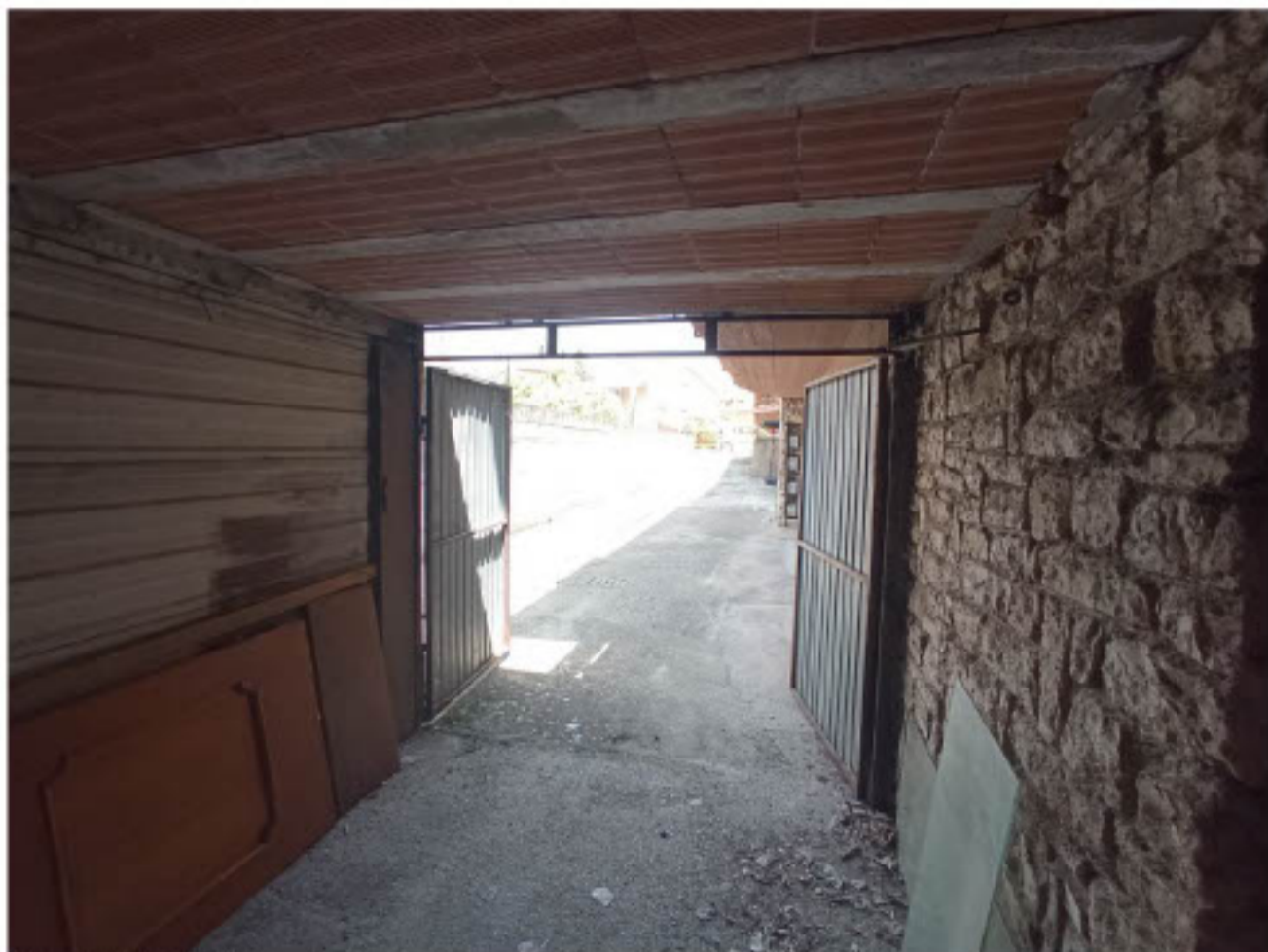
12 – INTERNO – Autorimessa – Sub 5
