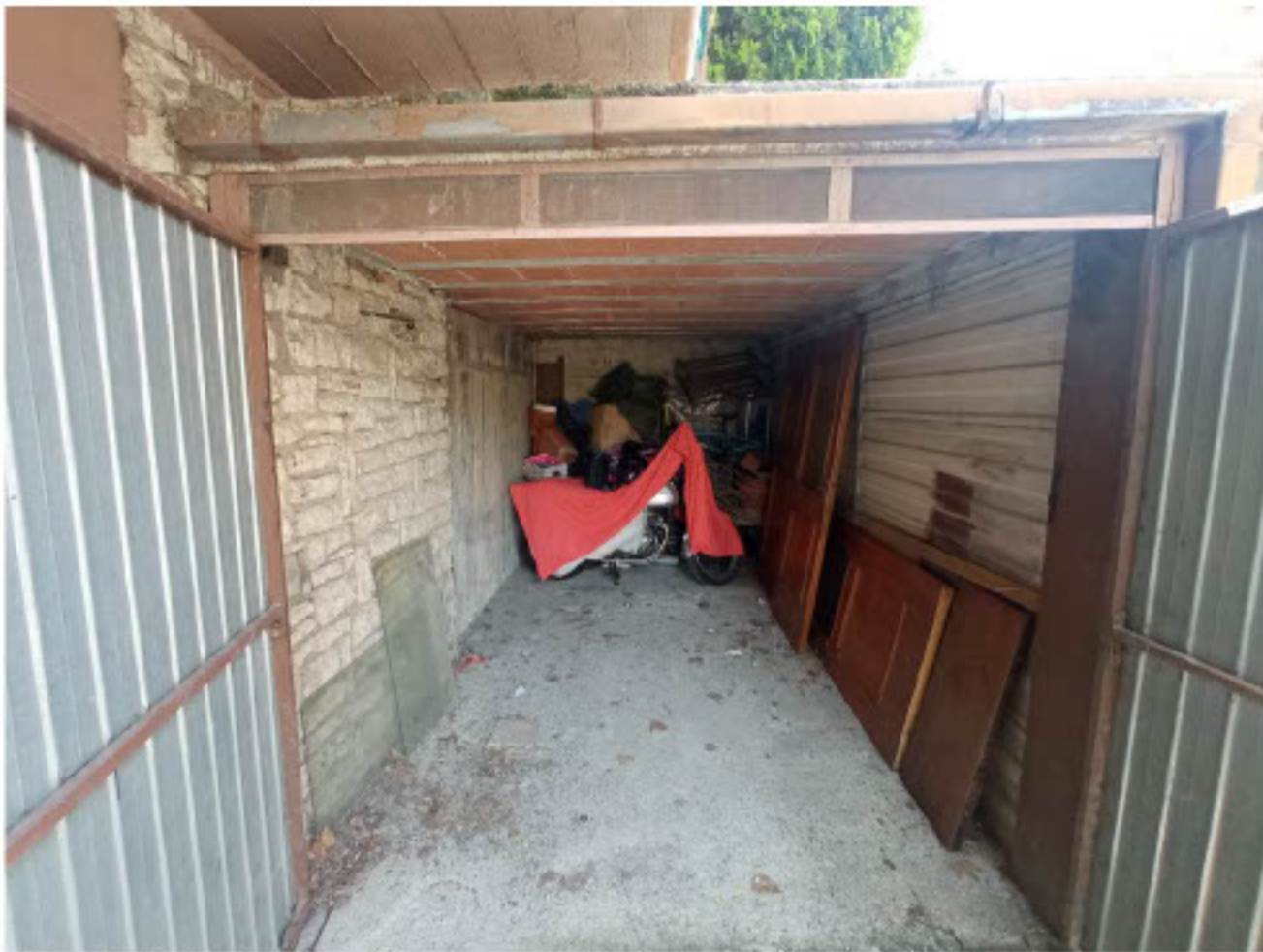
11 – INTERNO – Autorimessa – Sub 5
