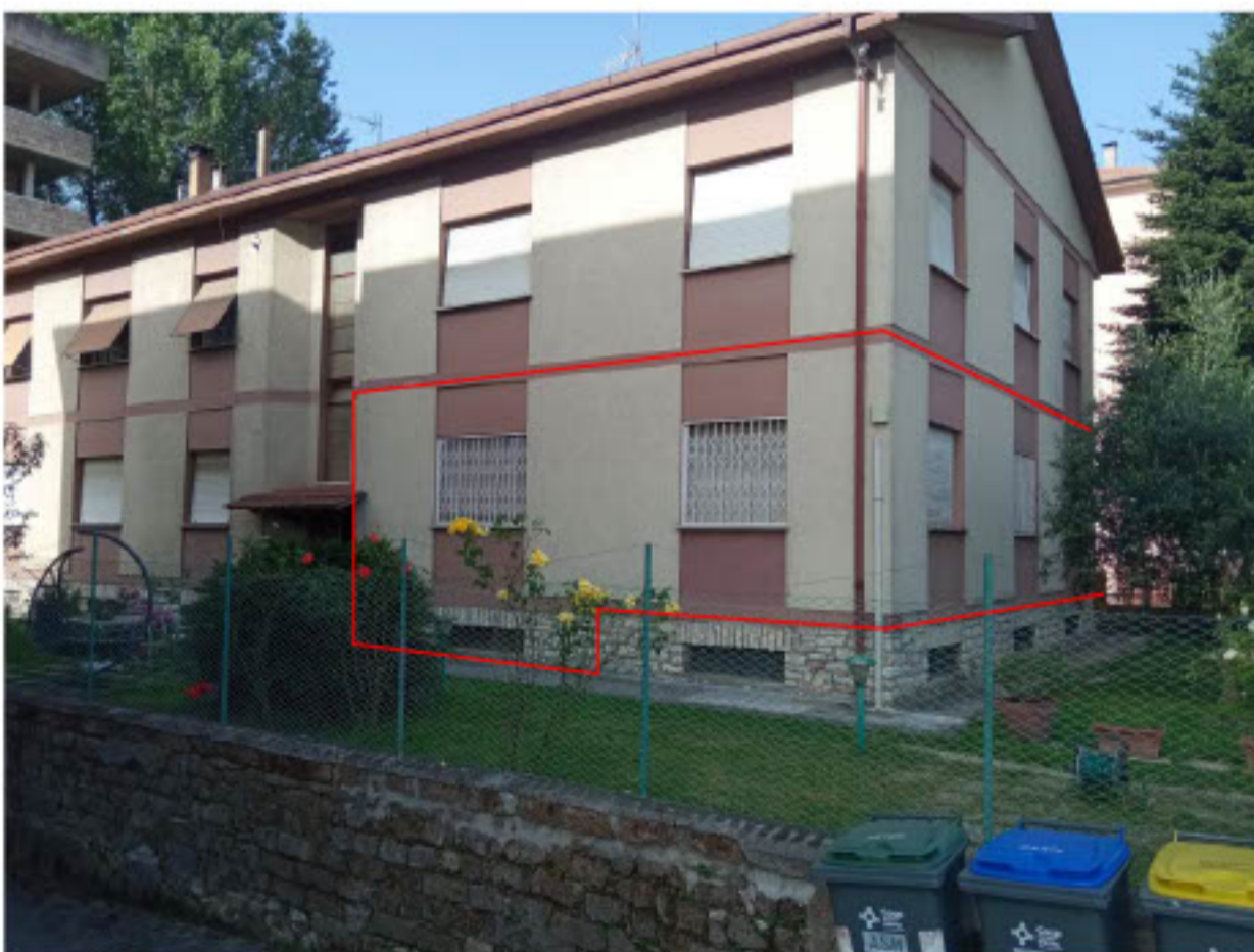
2 – ESTERNO – Angolo prospetti est e nord – Sub 3
