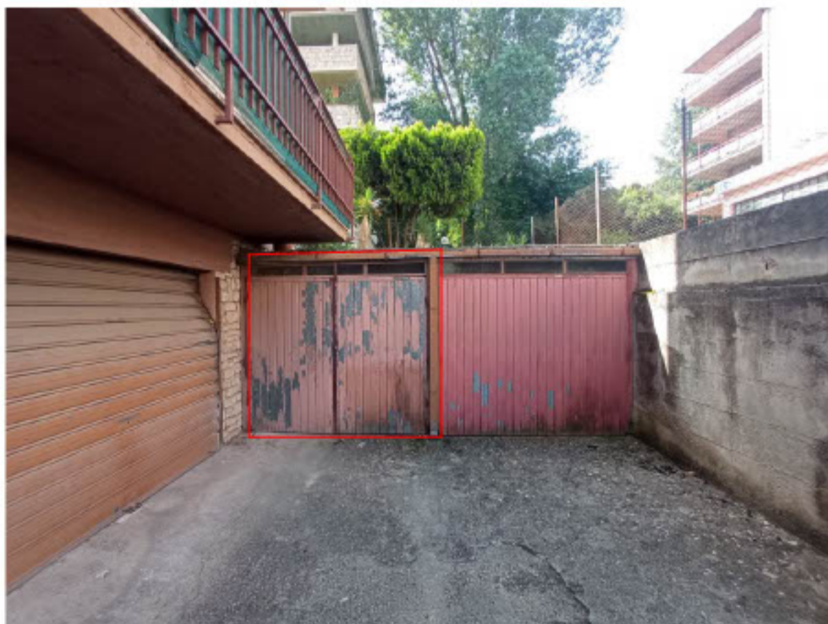
10 – ESTERNO – Autorimessa – Sub 5
