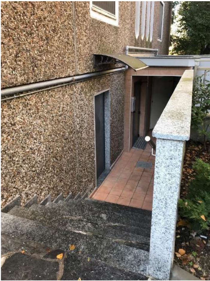
Scala di accesso alle cantine
