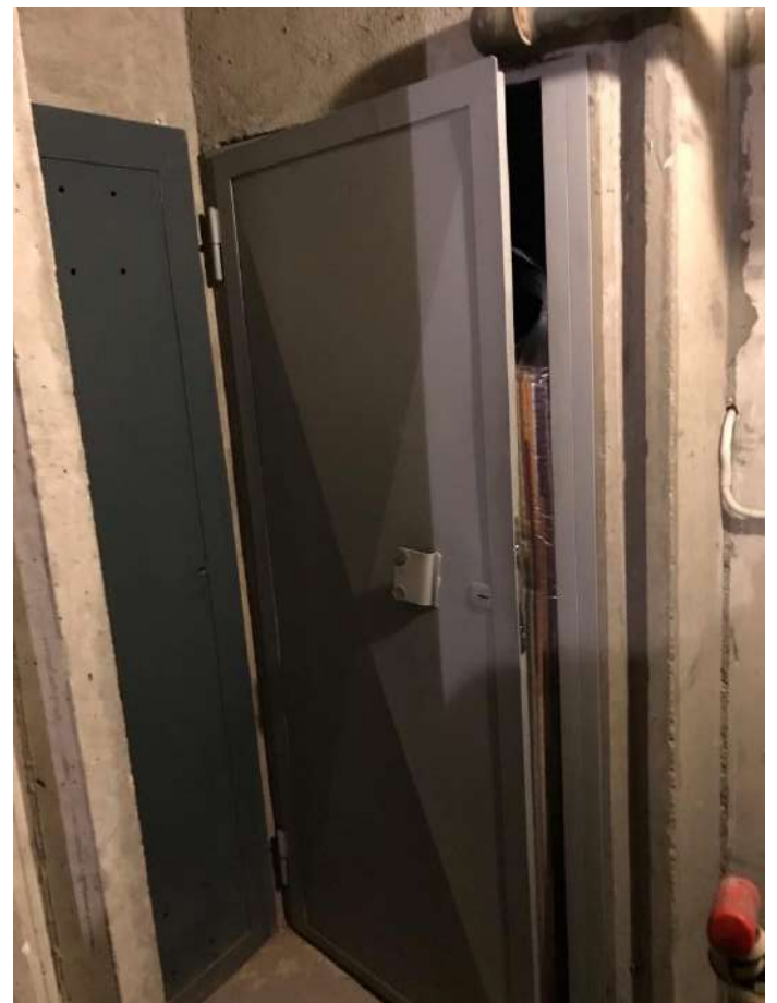
Porta ingresso cantina
