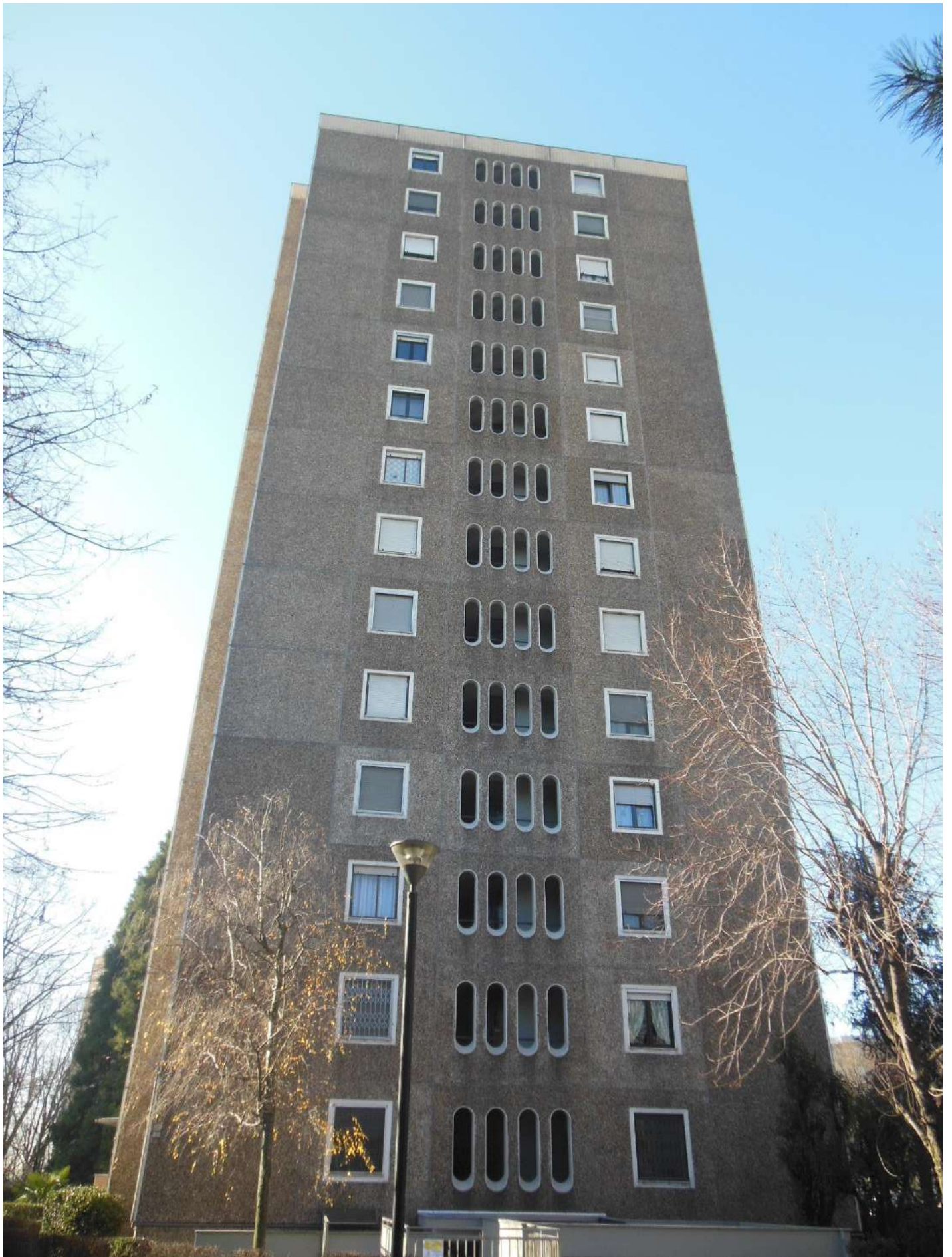
Edificio di Via Borsa 69
