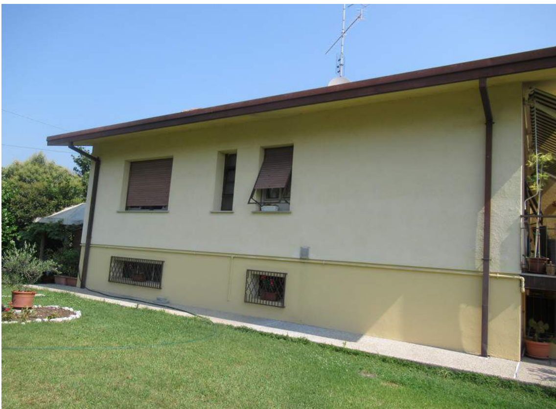
Foto 4: Facciata a Sud
