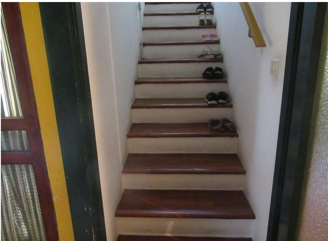
Foto 22: Scale interne dal piano seminterrato
