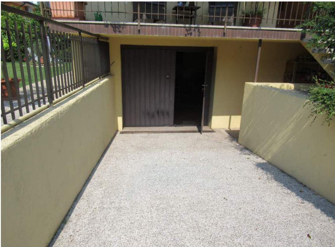
Foto 9: Accesso al garage
