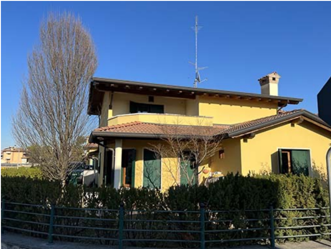
Ingresso abitazione da Via Fratelli Bandiera
