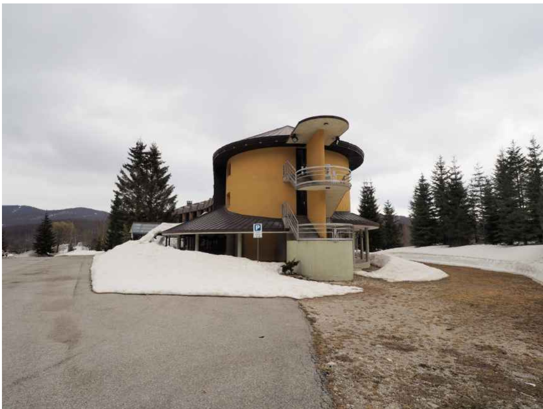
Piancavallo, via Barcis – Sopra il prospetto Nord, sotto il prospetto Ovest.
