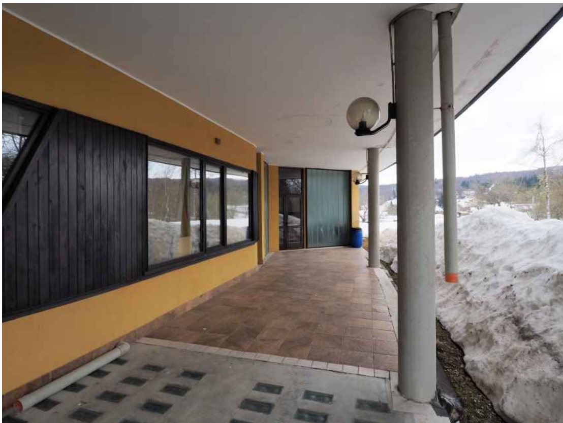
Piancavallo, via Barcis – Il percorso pedonale coperto a sud.
