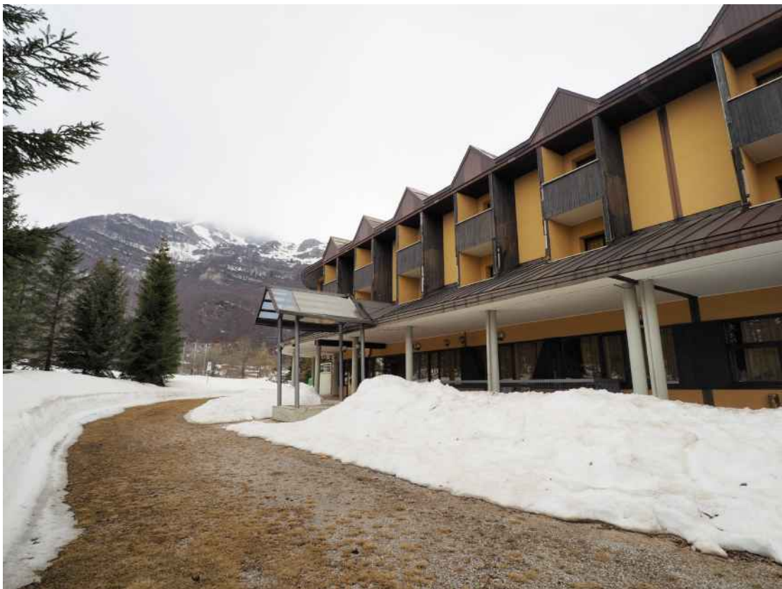
Piancavallo, via Barcis – Il prospetto Sud.
