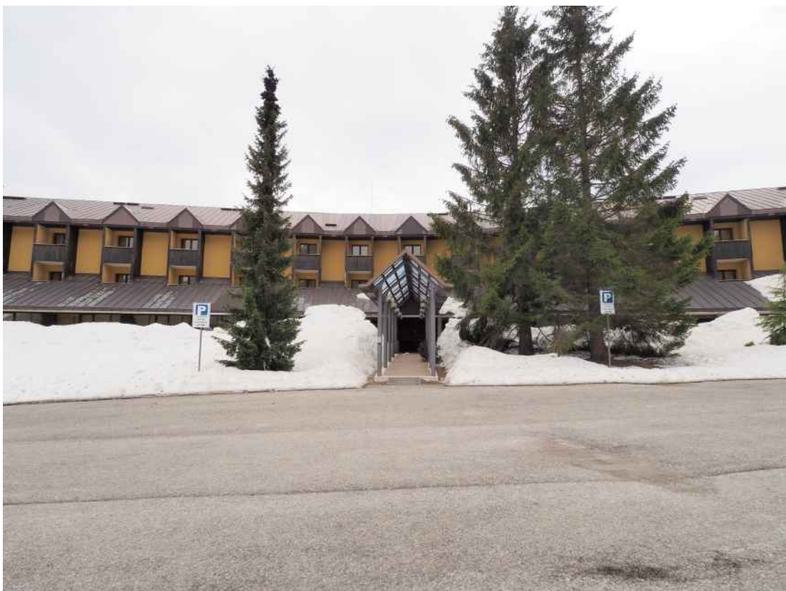
Piancavallo, via Barcis – Il prospetto Nord.
