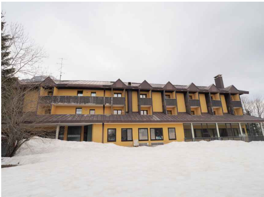
Piancavallo, via Barcis – Il prospetto Sud.
