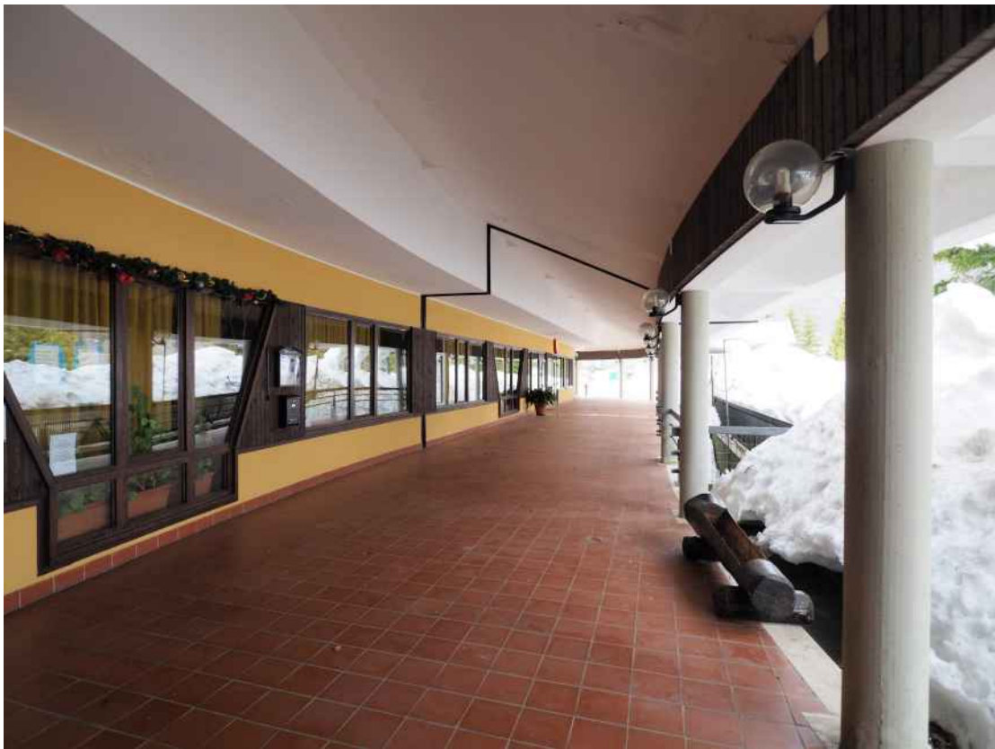
Piancavallo, via Barcis – Il percorso pedonale coperto a nord.
