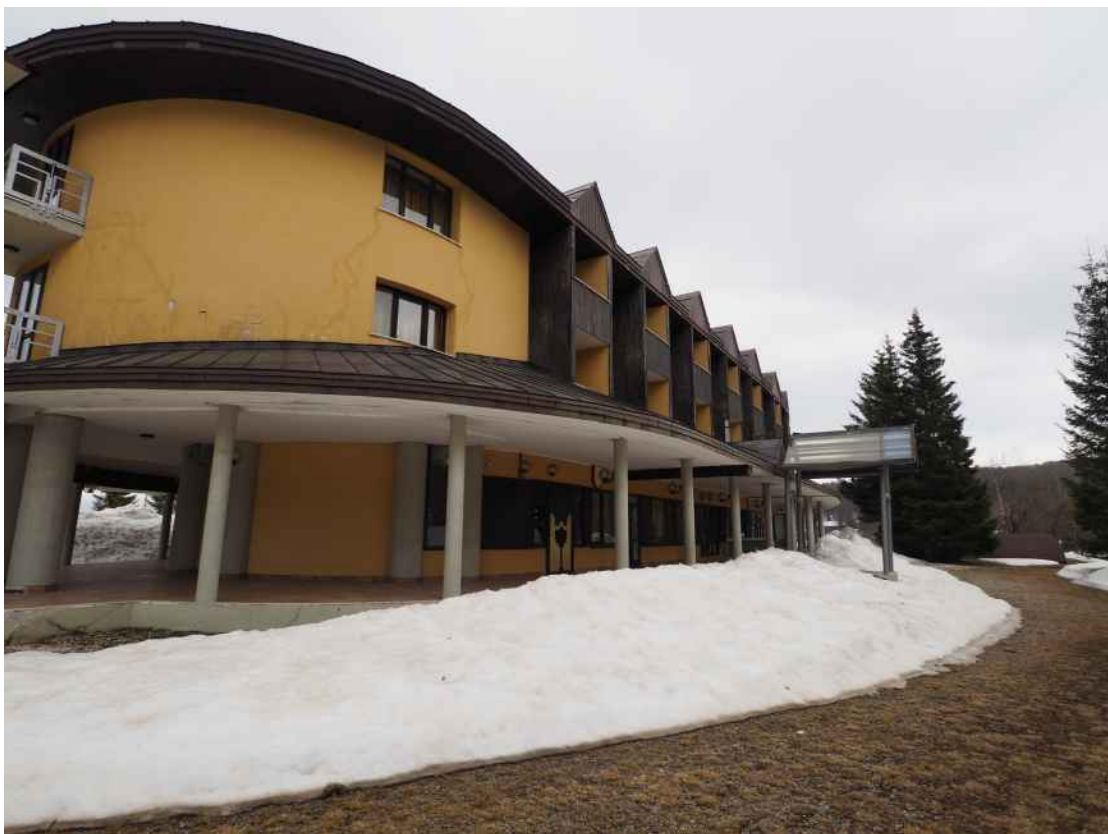
Piancavallo, via Barcis – Il prospetto Sud.
