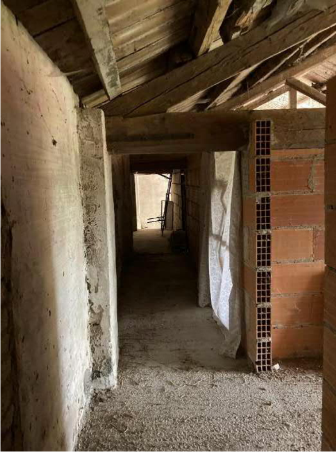
FOTO n. 33: corridoio d'ingresso al magazzino
