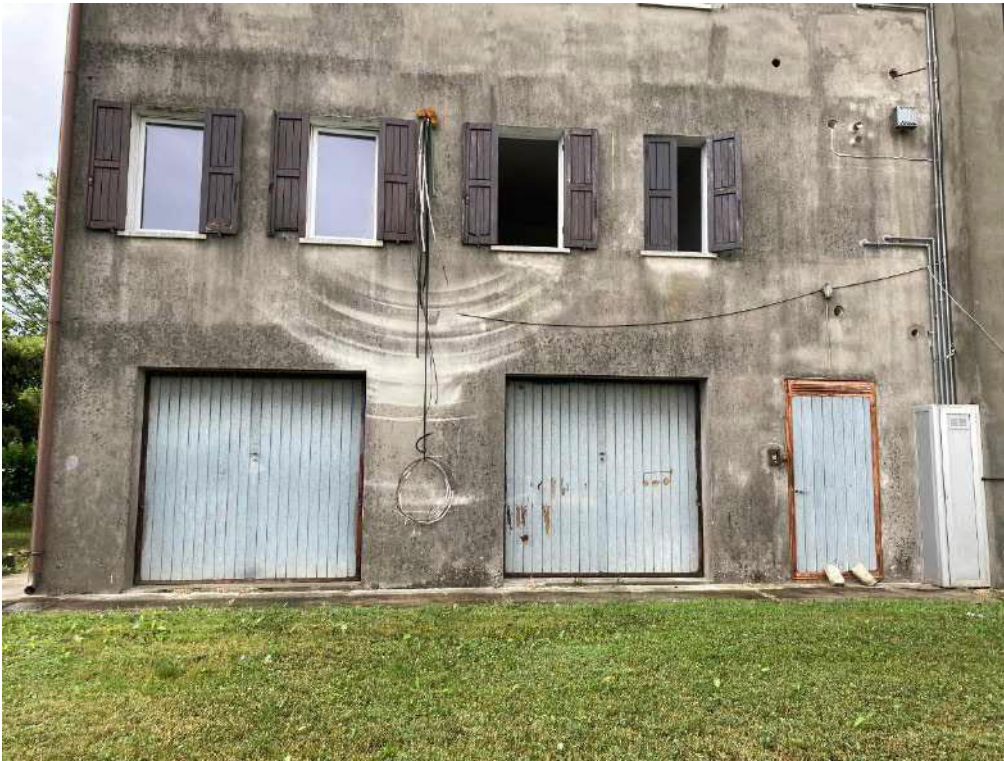
Foto n. 27: ingresso a nord al garage sub 5
