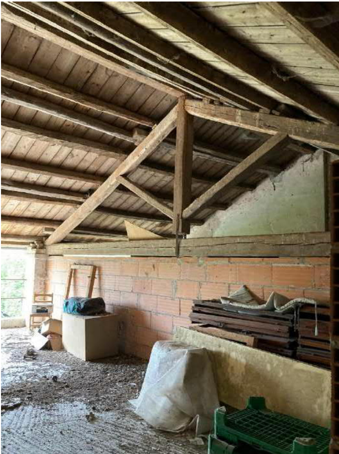
FOTO n. 35: vista copertura dal magazzino
