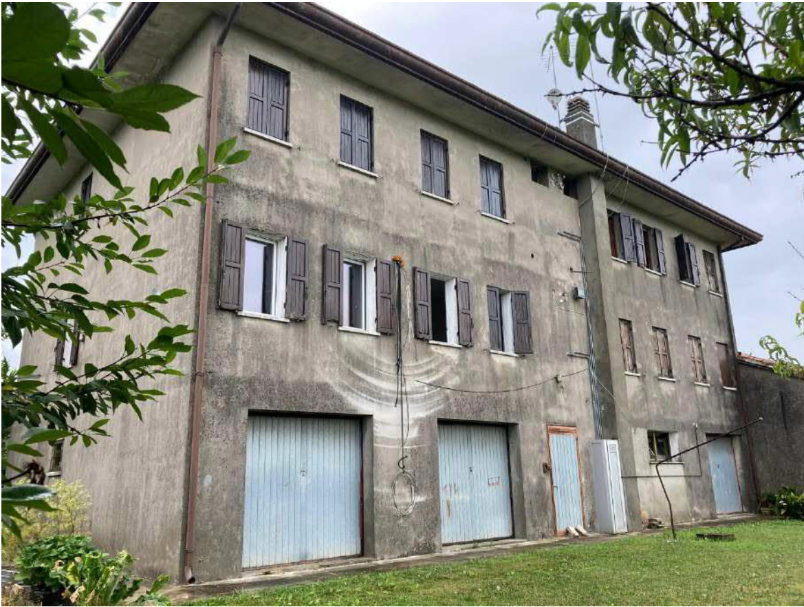
Foto n. 21: vista fabbricato da nord
