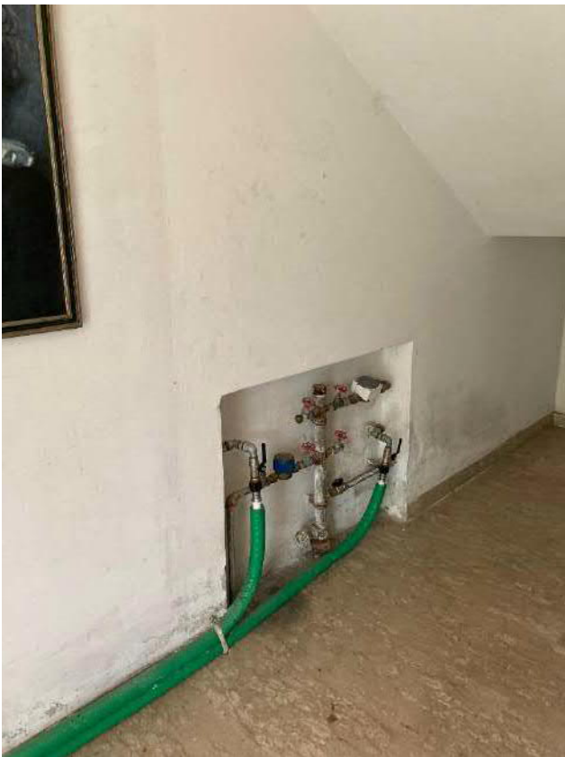
Foto n. 17: allacciamenti vano scala condominiale
