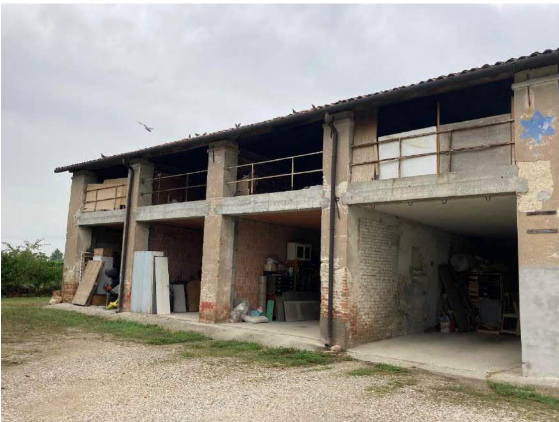
Foto n. 28: vista del fabbricato
