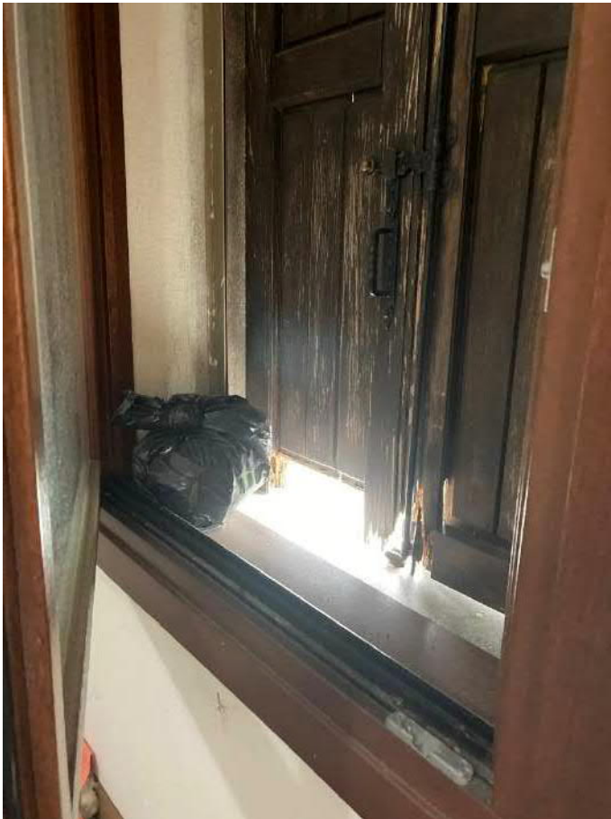
Foto n. 24: condizioni di alcuni oscuri (nord)
