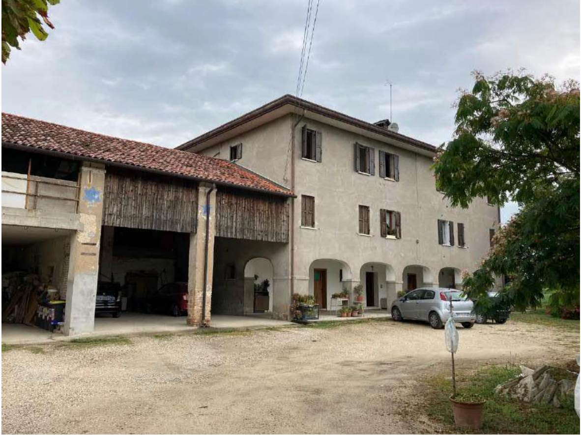
Foto n. 3: vista fabbricato da sud
