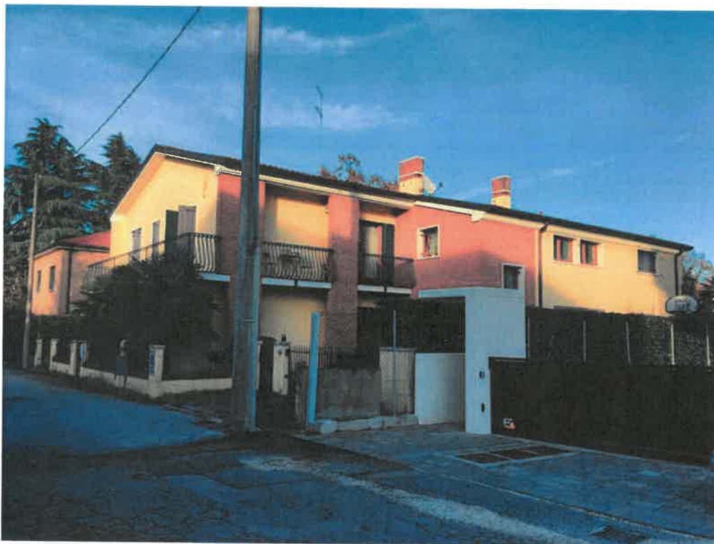
Foto n. 1: Vista del fabbricato da nord-ovest
