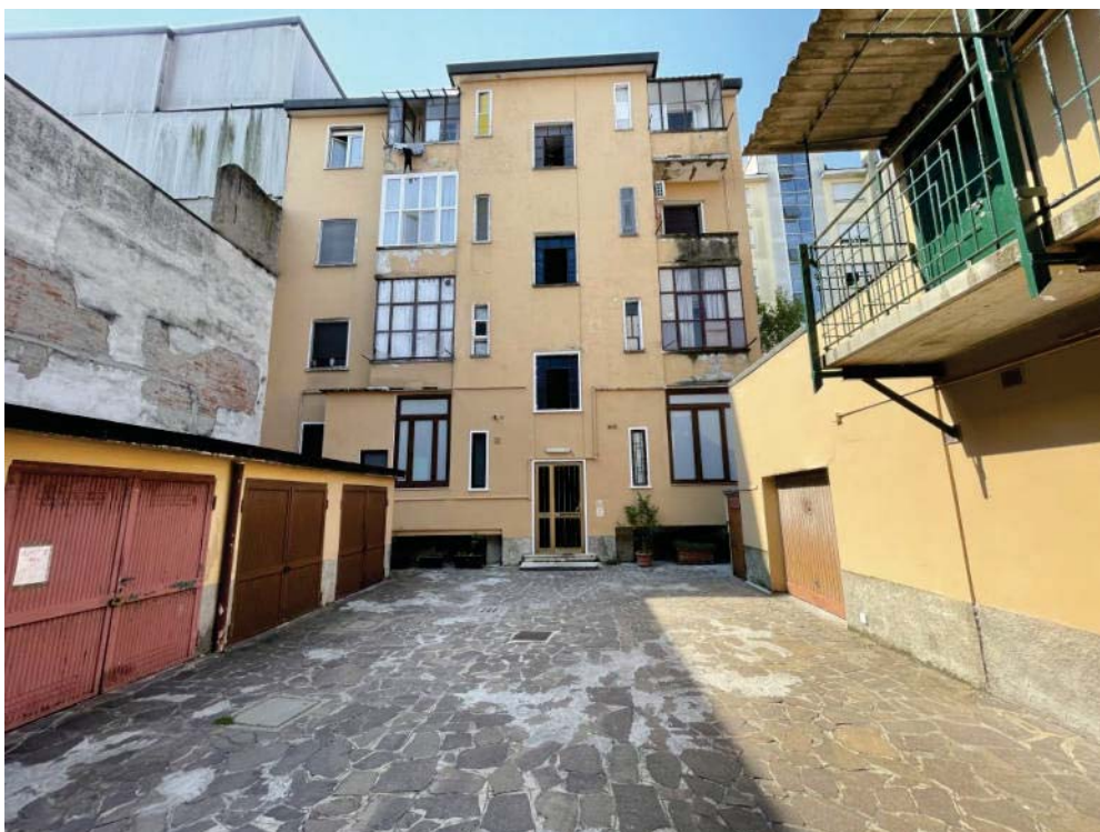
FOTO 2: MILANO, VIA MONTECASSINO 24, prospetto su cortile interno
