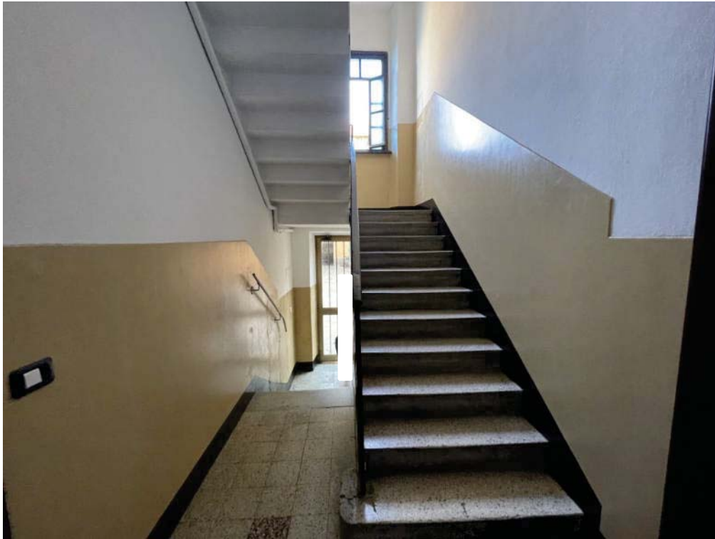
FOTO 3: MILANO, VIA MONTECASSINO 24, vano scala
