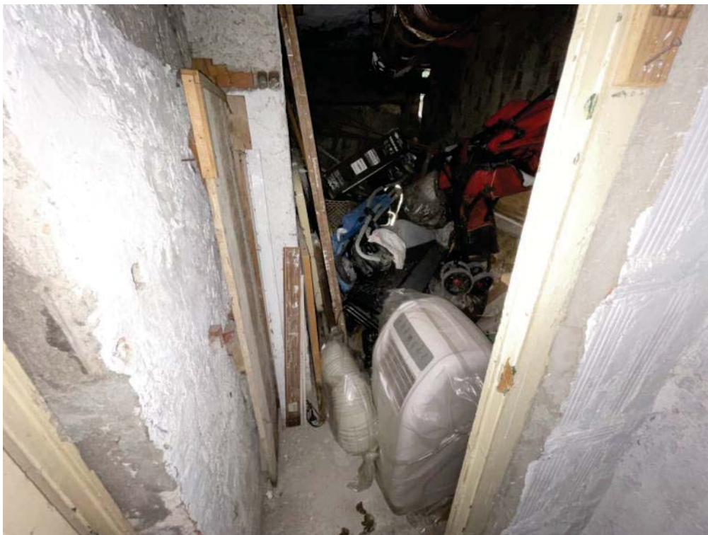
FOTO 11: MILANO, VIA MONTECASSINO 24, cantina
