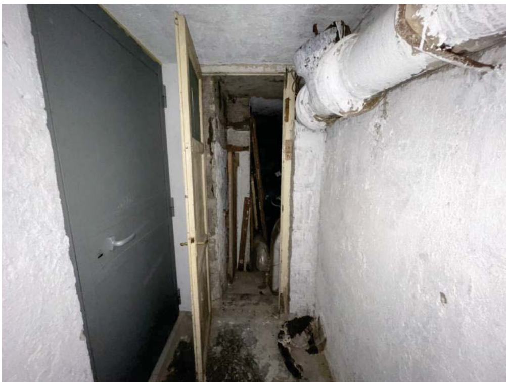
FOTO 10: MILANO, VIA MONTECASSINO 24, accesso alla cantina
