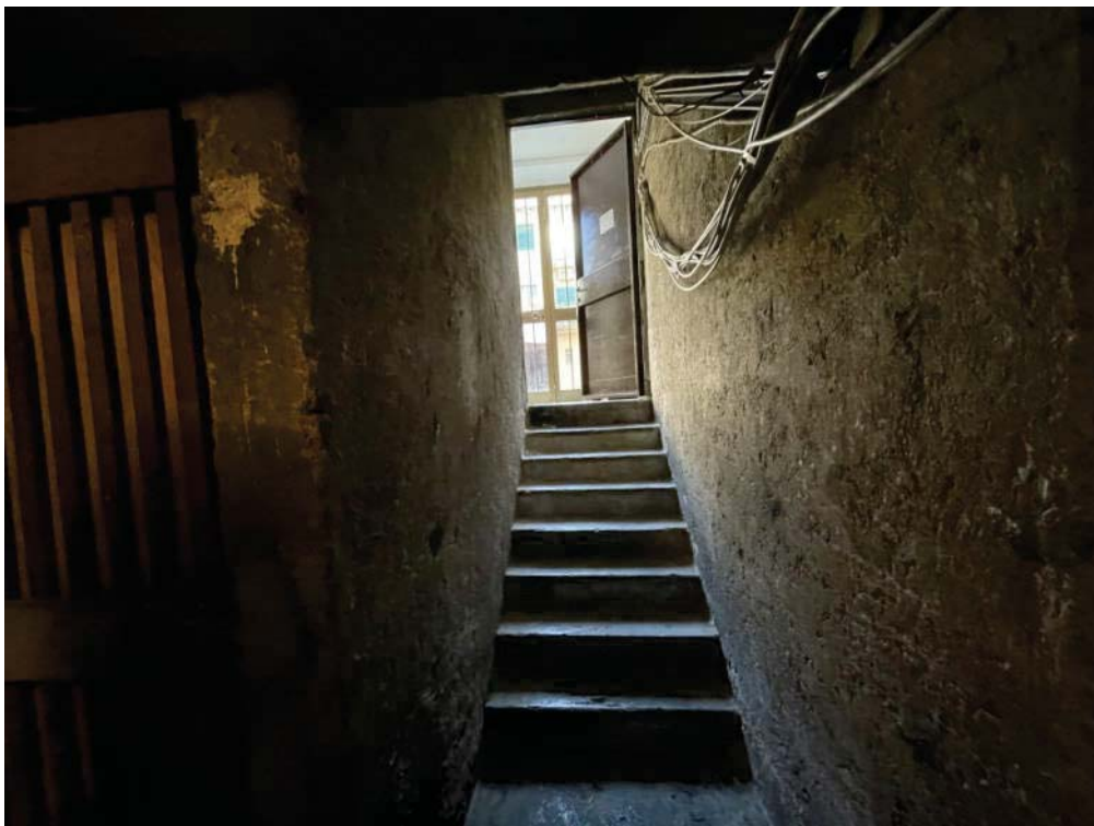
FOTO 9: MILANO, VIA MONTECASSINO 24, accesso al piano cantine
