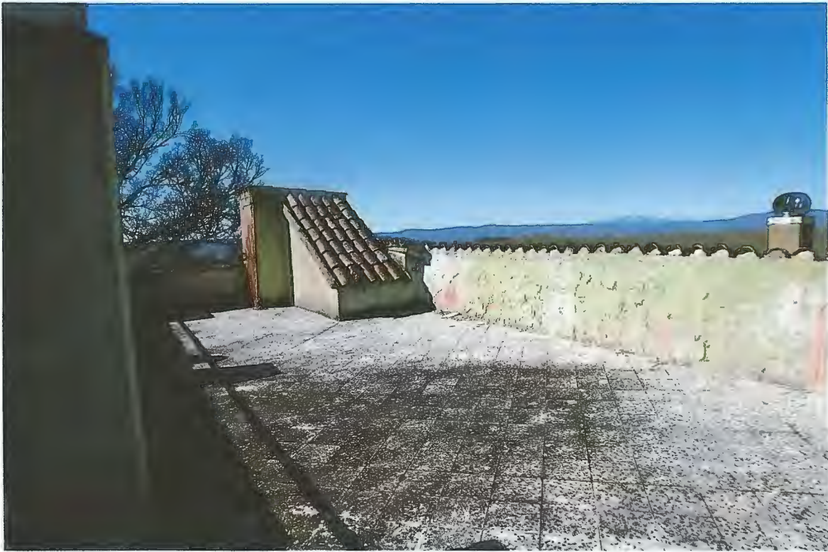
19) Vista esterna terrazzo piano 2°;
