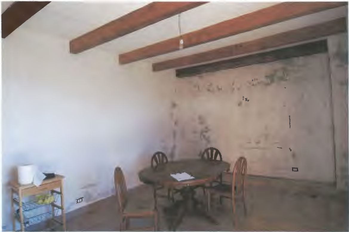
5) Vista vano n. 1 (soggiorno);
