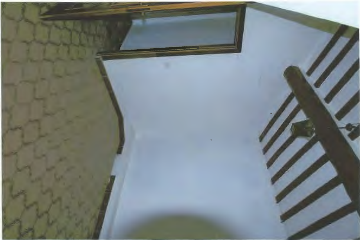
15) Vista interna camera – vano 8;
