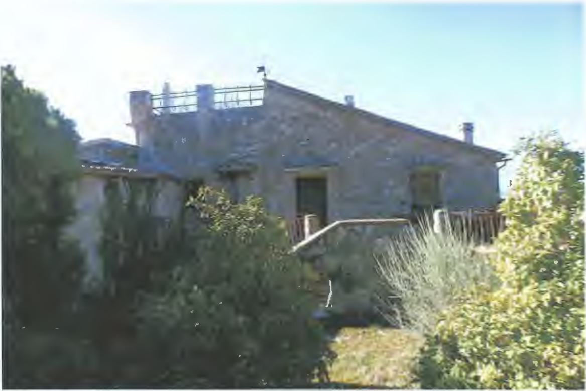
1) Vista esterna lato nord;
