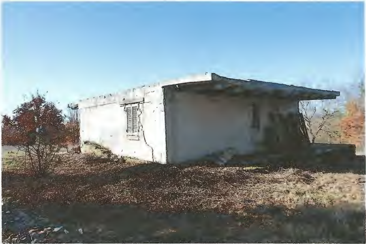
1) Vista immobile lati nord e est;
