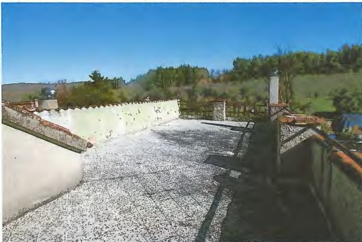
17) Vista esterna terrazzo piano 2°;
