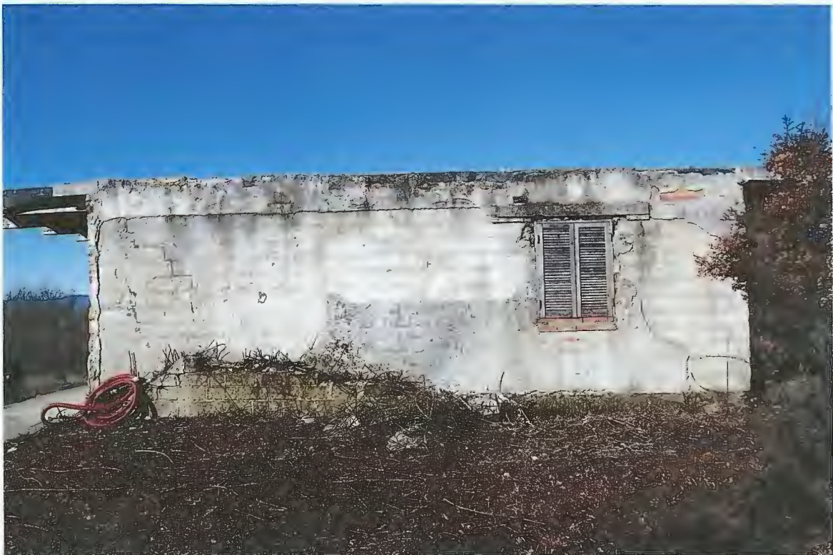
4) Vista immobile lato est;
