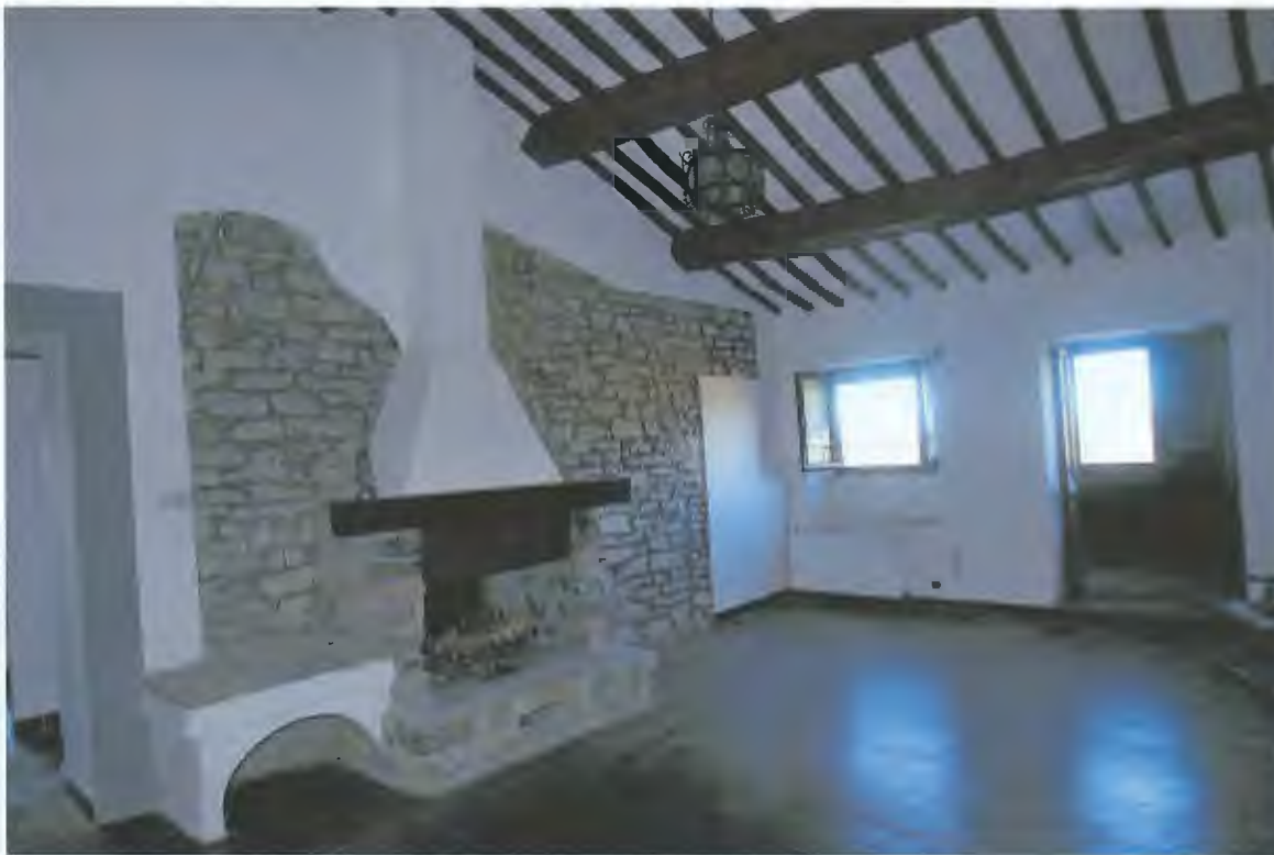
7) Vista interna soggiorno – vano 2;
