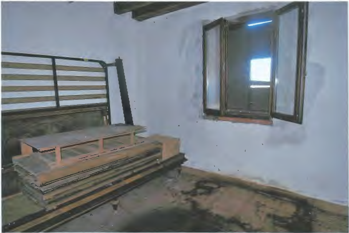
7) Vista interna vano n. 3;
