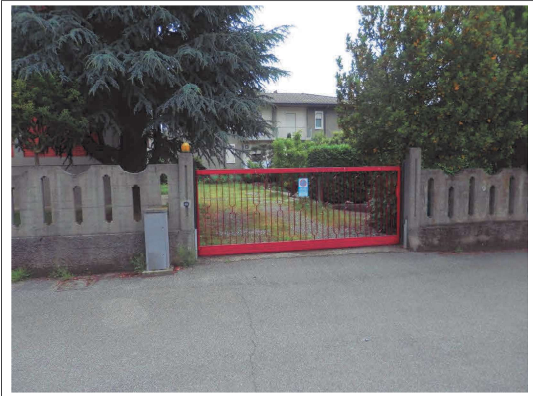
Fotografia n°1 – Vista dell'accesso carraio al complesso edilizia.
