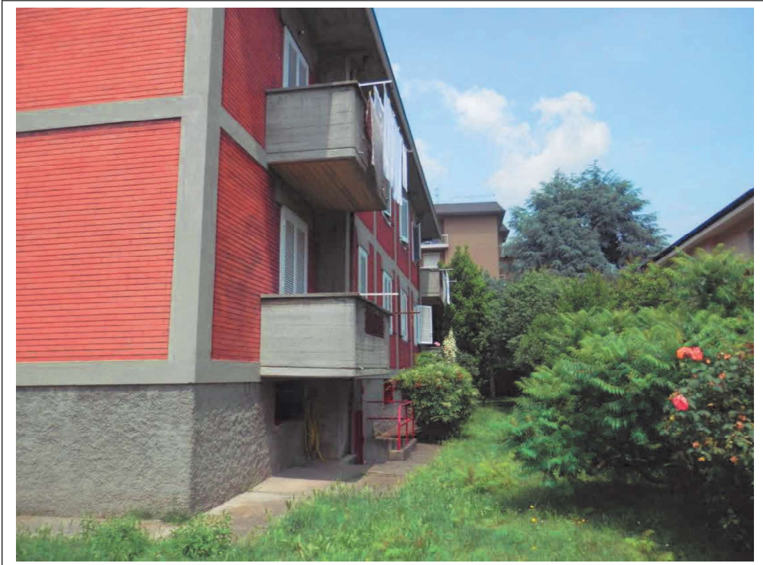
Fotografia n°3 – Vista della facciata del fabbricato residenziale rivolta a Sud-Ovest.
