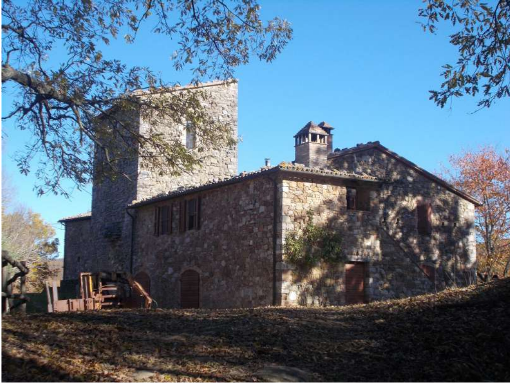
Foto n. 12: vista del fabbricato lato ovest e sud (corpo scala).
