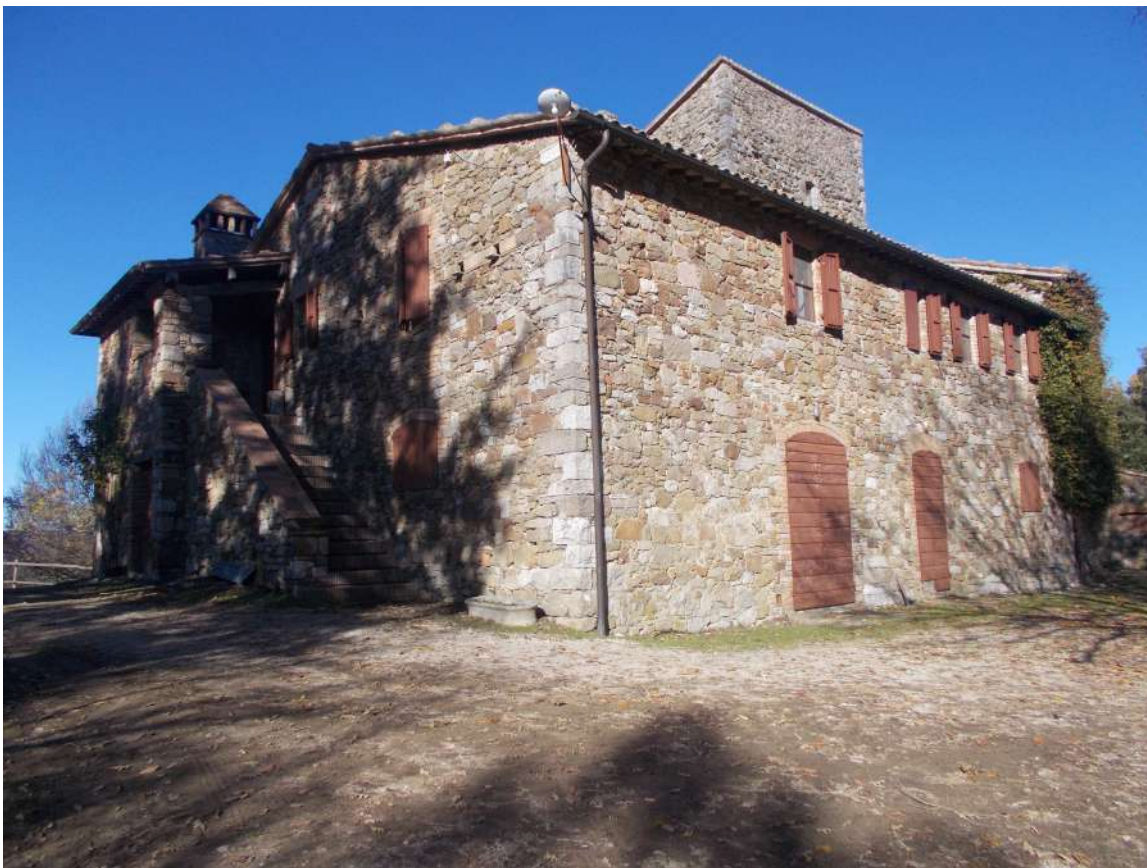
Foto n. 05: vista del fabbricato dalla corte di pertinenza.
