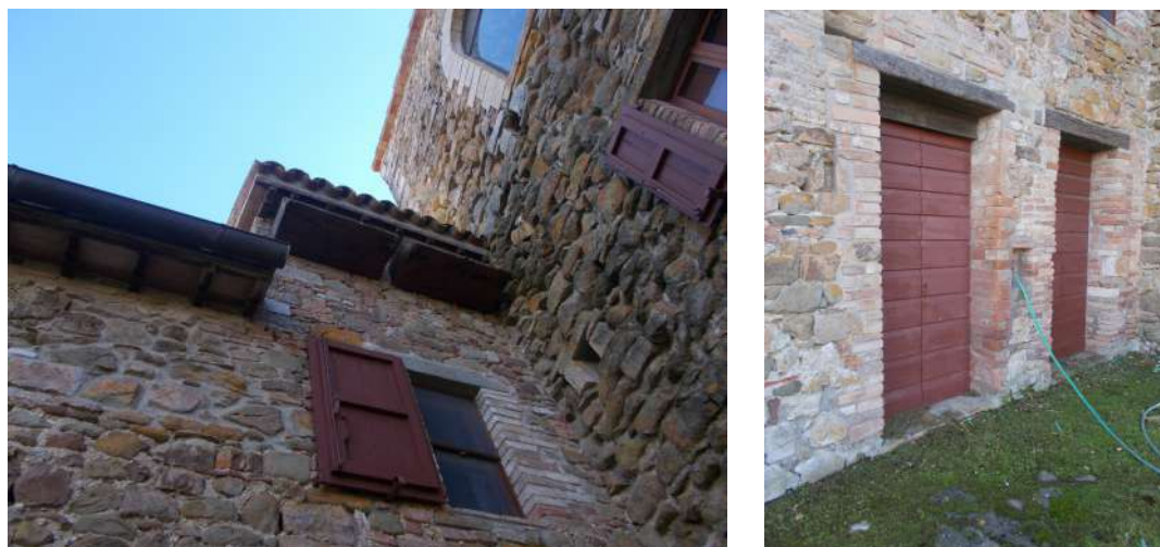
Foto n. 18-19: dettaglio particolari architettonici lato ovest.
