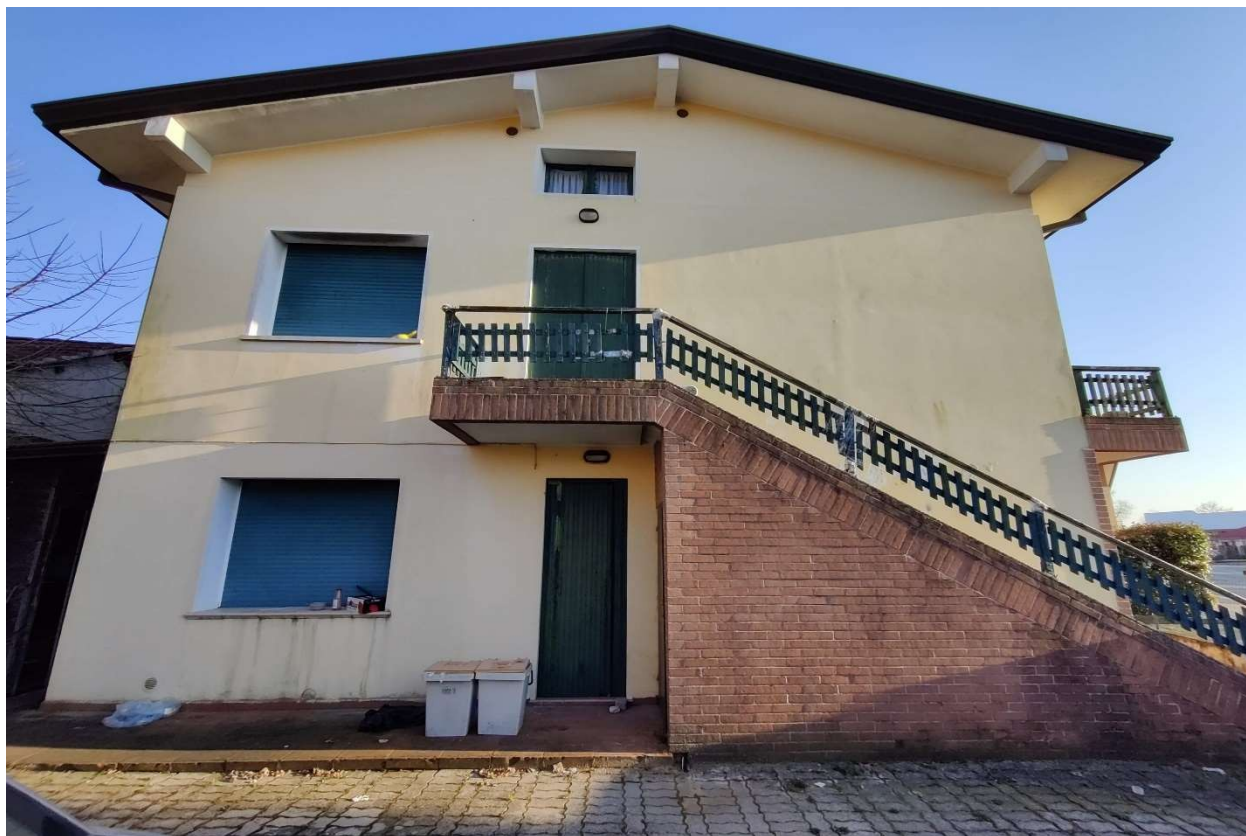
Foto n. 4 - Facciata Nord vista dal cortile interno.
