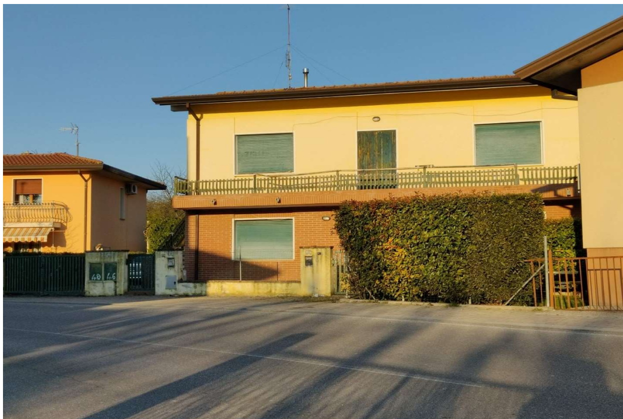
Foto n. 2 - Abitazione vista da via Capitello (facciata rivolta ad Ovest).
