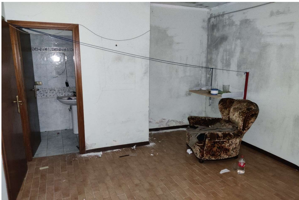
Foto n. 18 - Camera con servizi igienici.
