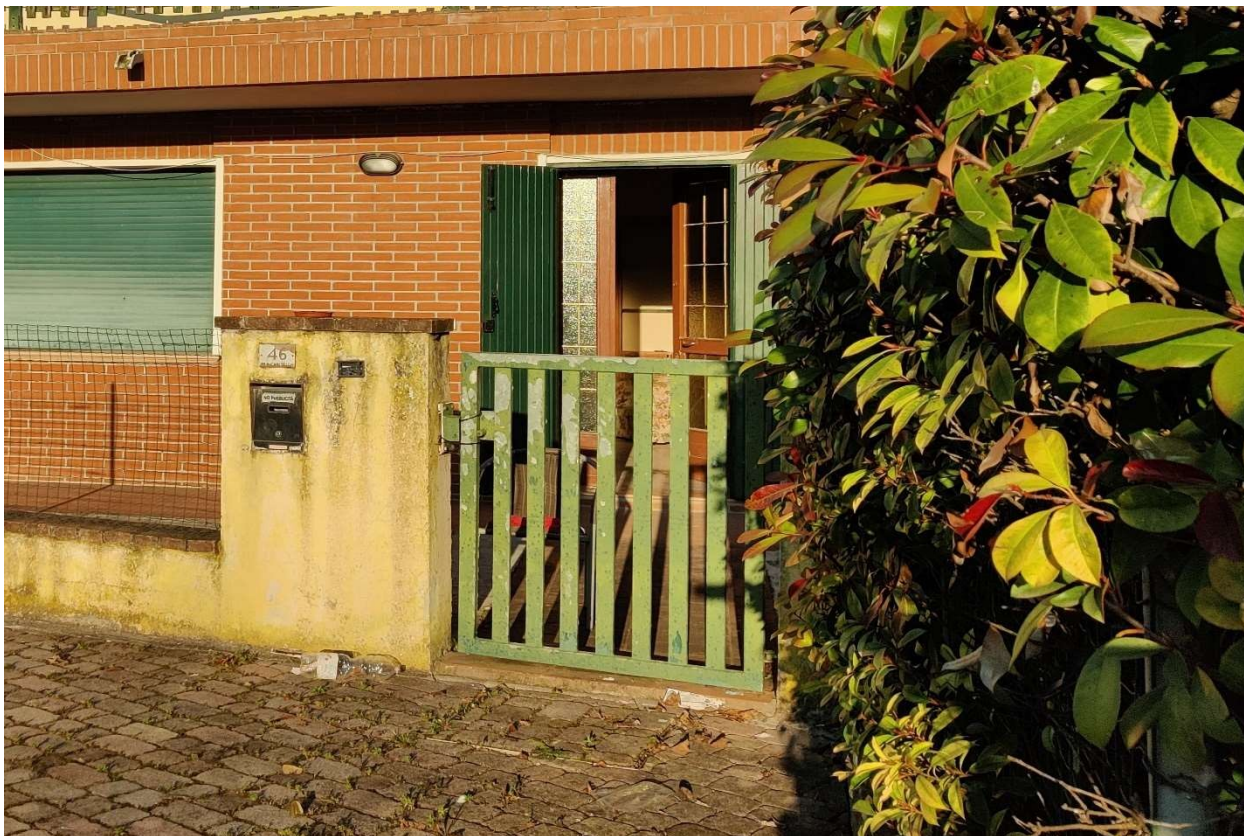
Foto n. 5 - Accesso da via Capitello: in evidenza il cancello pedonale e, sull'edificio, gli scuri ed il portoncino di ingresso.
