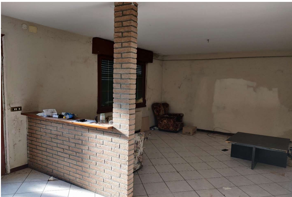
Foto n. 9 - Ingresso soggiorno, con manufatto in mattone pieno.
