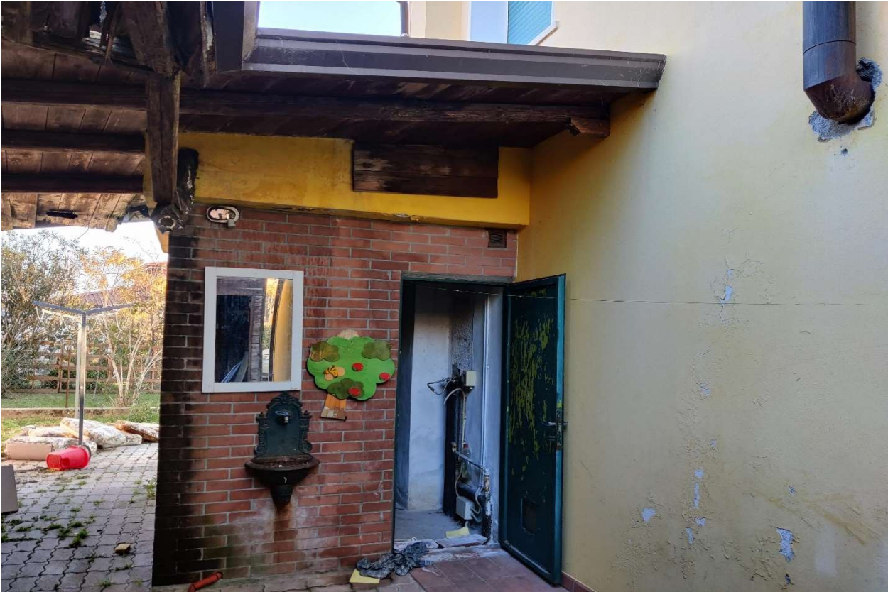
Foto n. 27 - Vano accessibile dall'esterno dove dovevano essere alloggiate le caldaie delle due unità abitative. All'interno è ricavata una piccola lavanderia.
