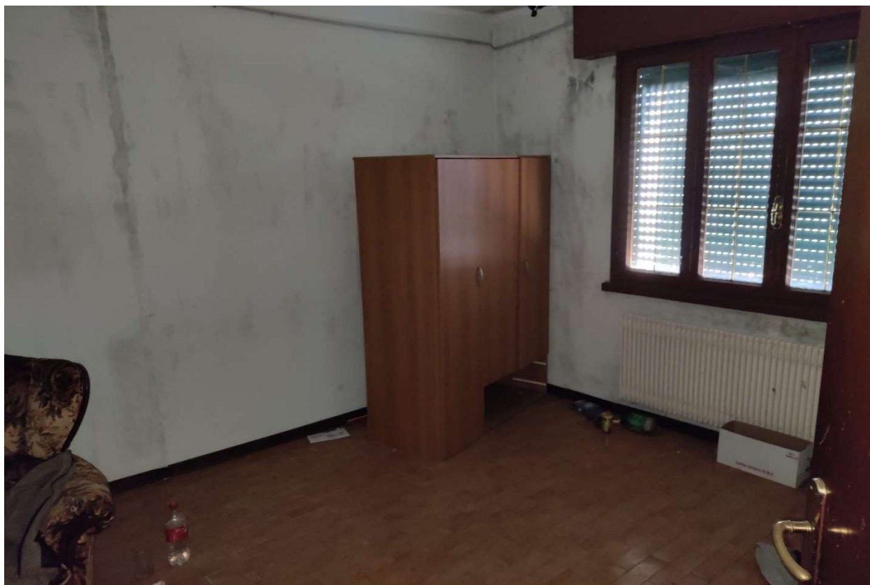
Foto n. 19 - Camera con servizi igienici.
