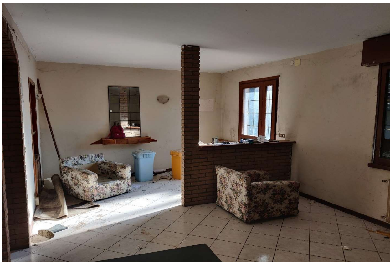
Foto n. 7 - Ingresso soggiorno, con manufatto in mattone pieno.
