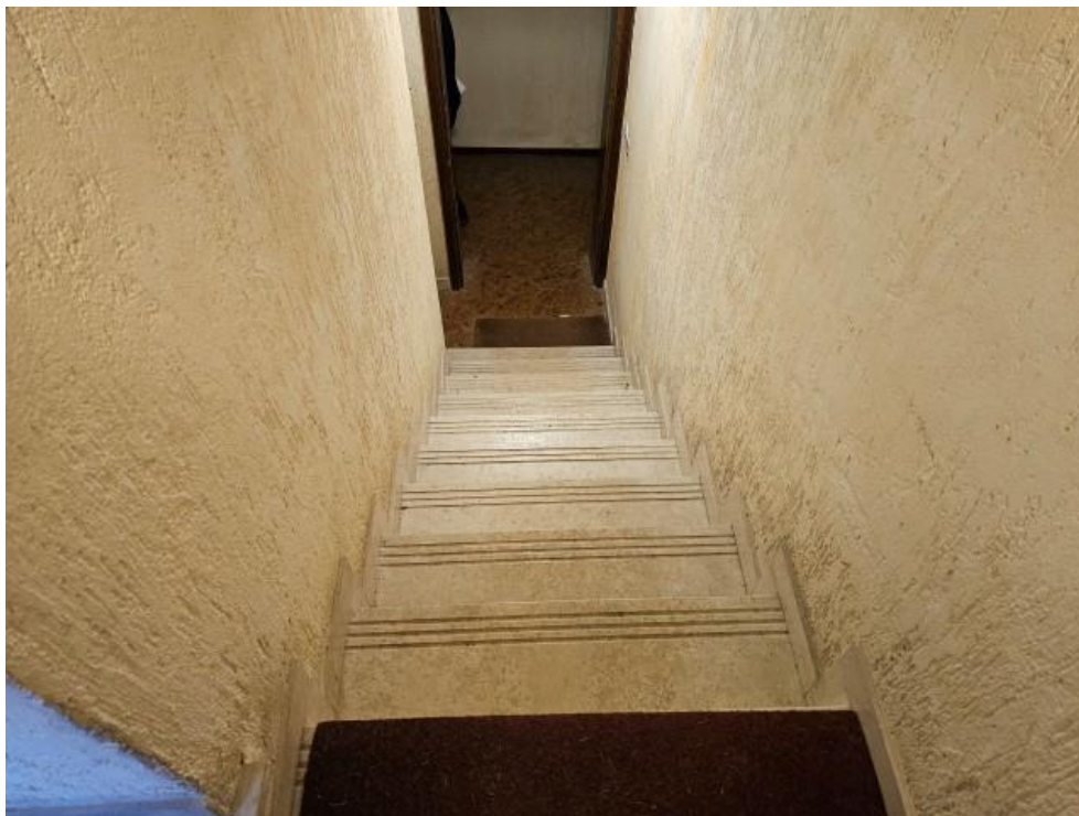
FOTO 9: VANO SCALE CONDOMINIALE
