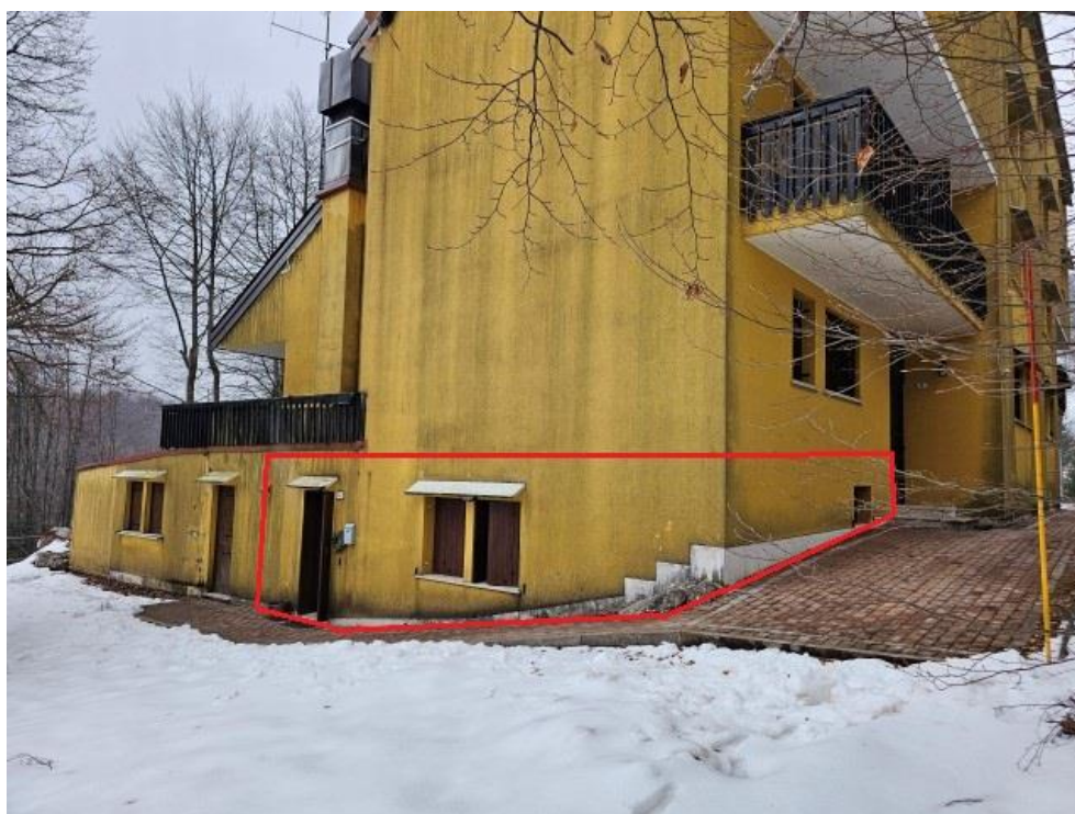
FOTO 6: PANORAMICA CONDOMINIO PEONIA E SUB. 38 EVIDENZIATO
