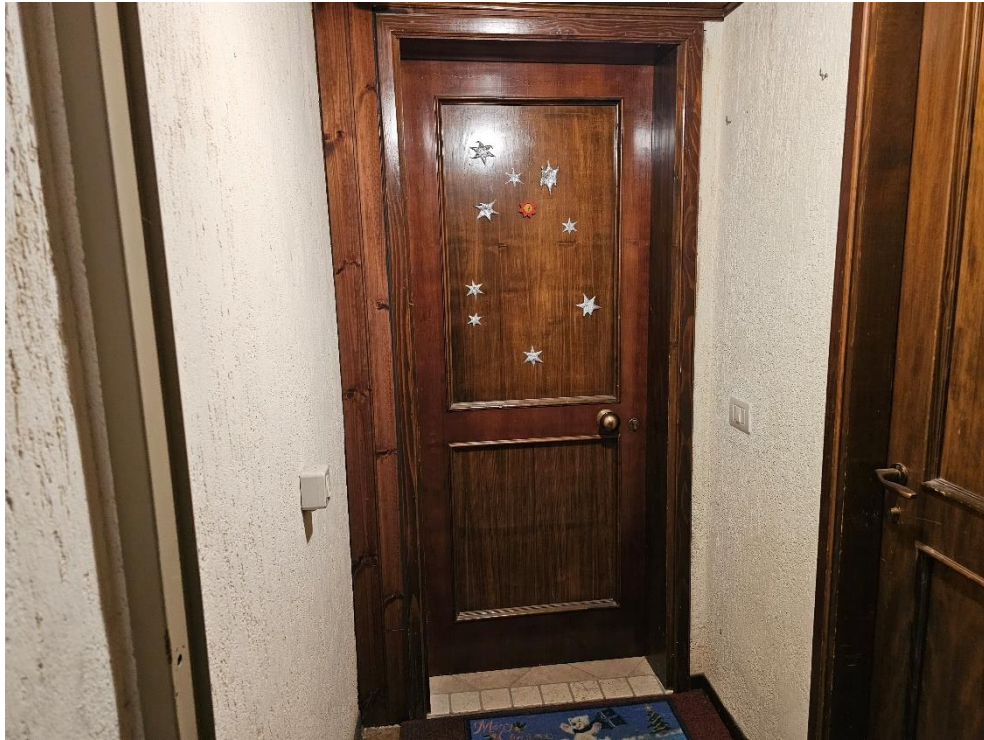
FOTO 11: INGRESSO SUBALTERNO N. 38 DA VANO SCALE CONDOMINIALE
