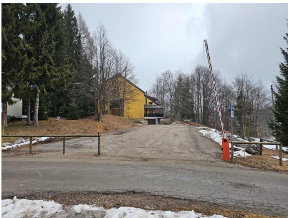
FOTO 2: ACCESSO AREA PARCHEGGIO CONDOMINIO PEONIA
