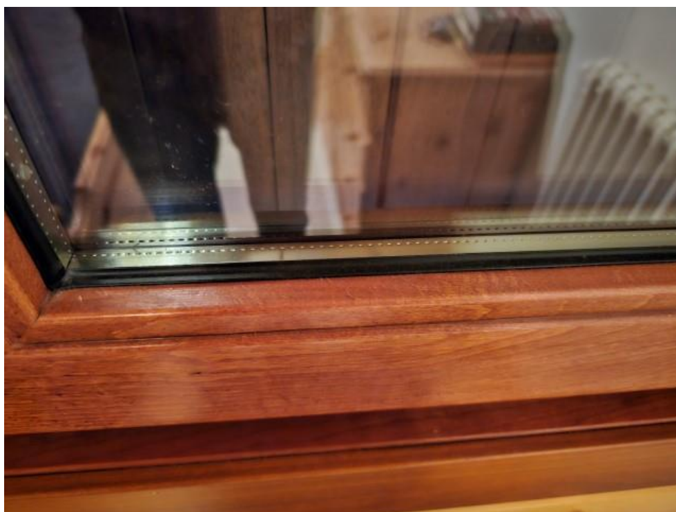
FOTO 22: PARTICOLARE SERRAMENTO (Subalterno n. 38)
